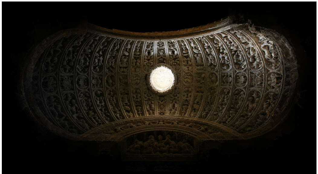
Fig. 2. Nuvola di punti della volta della Capilla de Junterón (elaborazione digitale A. Bortot).
