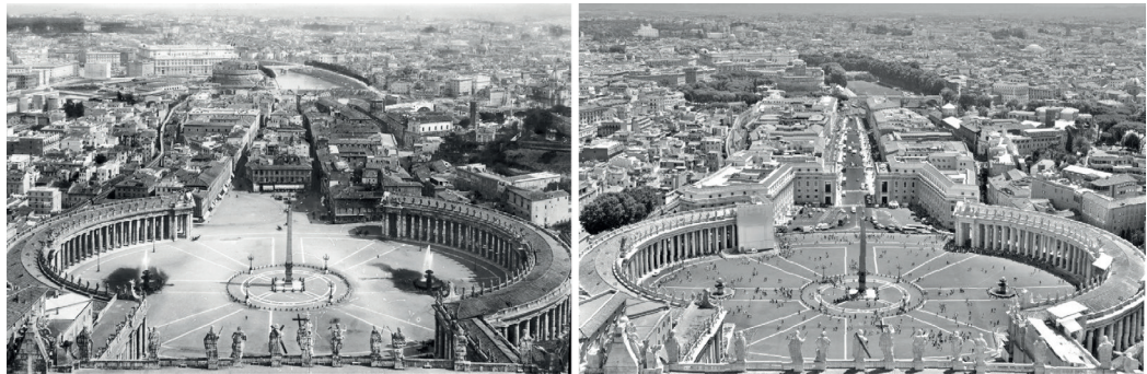
Fig. 1. Due fotografie storiche che mostrano il radicale cambiamento dell'assetto urbano durante gli sventramenti che hanno stravolto il tessuto romano negli anni Trenta del XX secolo. La Spina di Borgo (a destra), completamente rasa al suolo per l'apertura di via della Conciliazione nel 1937-38 (a sinistra). Fonte: archivio fotografico romasparita.eu.
