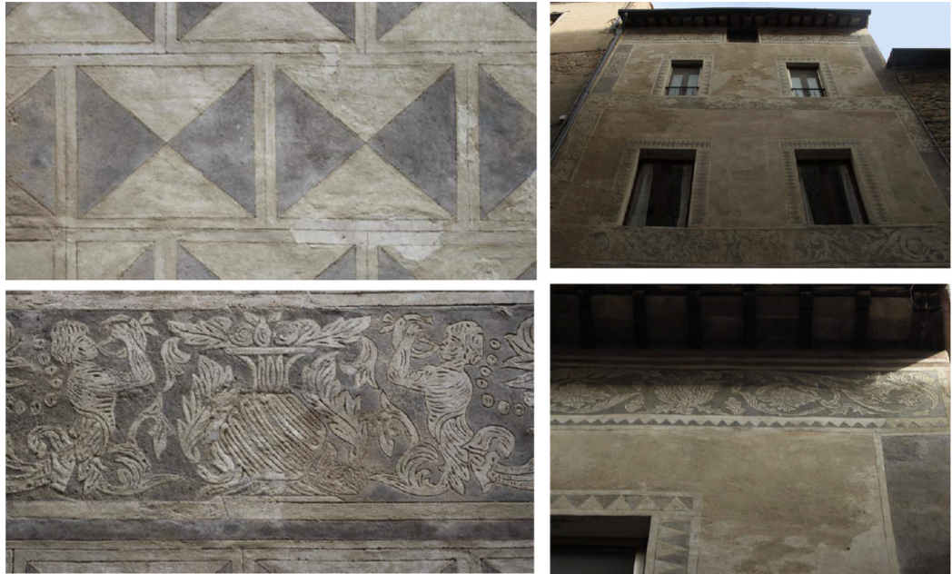
Fig. 8. Pienza, Palazzetti in corso il Rossellino, 85-87, 81-83, details (photos by the authors).
