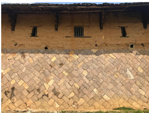
Fig. 7. Dettaglio di una porzione del grande muro fortificato in pietra e terra battuta (foto di M. Calia, marzo 2019).
