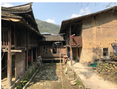
Fig. 4. Vista della corte interna di servizio, in cui sono evidenti i sistemi di attraversamento, di distribuzione mediante ballatoi e di raccolta delle acque (foto di M. Calia, marzo 2019).
