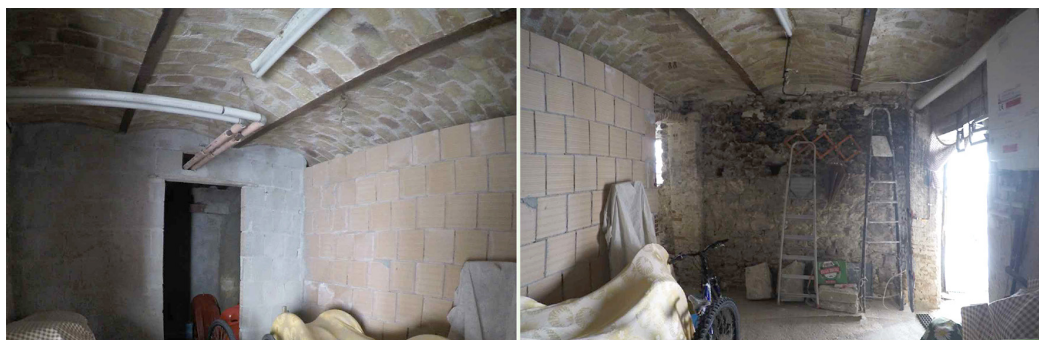
Fig. 8. Voltine in laterizio in un edificio a Castel del Monte (foto di V. Cetra).
