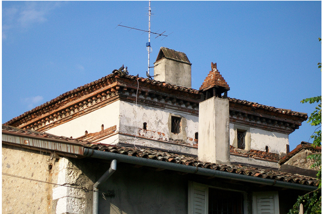
Fig. 4. Uso del laterizio in una torre colombaia di Gussago (Bs).
