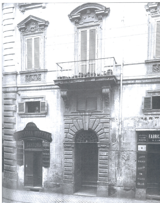
Fig. 2. Fotografia dell'edificio prima della demolizione al numero civico 7 in via Alessandrina [Delli 2007, vol. I].
