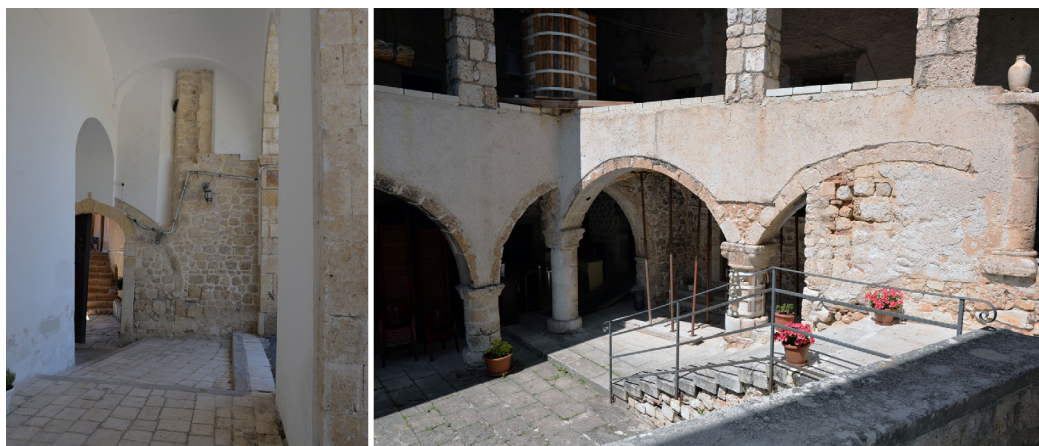
Fig. 2. Particolari dell'ingresso dell'abbazia e del cortile con l'evidenza della successione degli interventi effettuati nel tempo e delle superfetazioni architettoniche.
