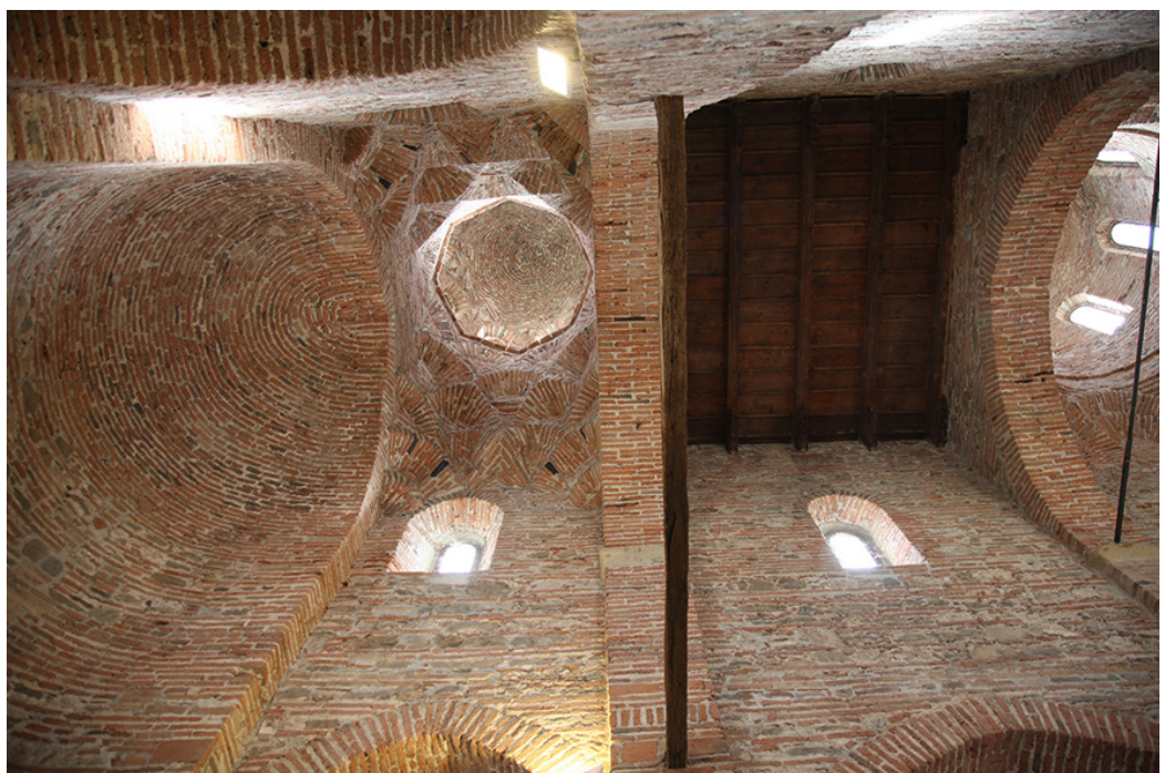
Fig. 3. San Pietro e Paolo d'Agrò, la cupola minore in prossimità dell'abside.
