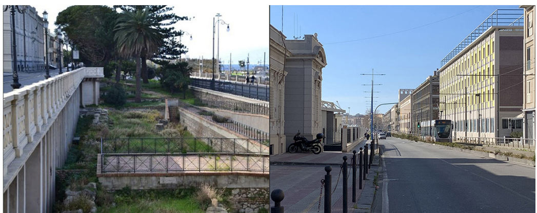
Fig. 2. Le due Palazzate, quella della Piazza dello Stretto e quella della Piazza urbana di Messina ed i due sistemi del Lungomare e dei cannocchiali ottici di Reggio Calabria.
