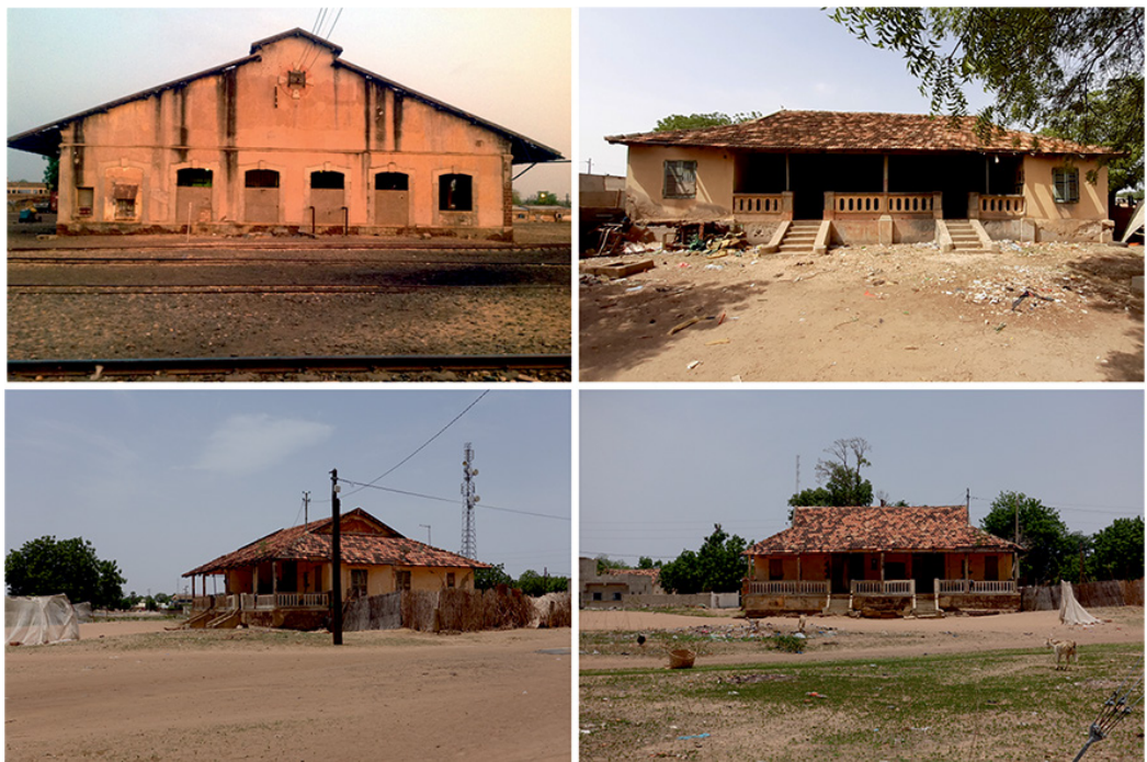
Fig. 7. Magazzino di Rialzo di Tambacounda e Case dei ferrovieri di Gossas, Bambey, Kaffrine.
