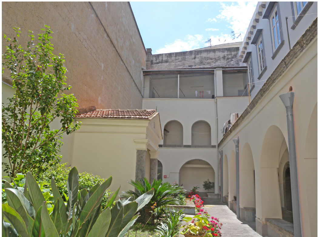
Fig. 9. Lo spazio del chiostro demolito si presenta ora come un giardino poco vivibile per la comunità religiosa. Sul fondo il prospetto del refettorio adiacente, ricostruito nel 2009.
