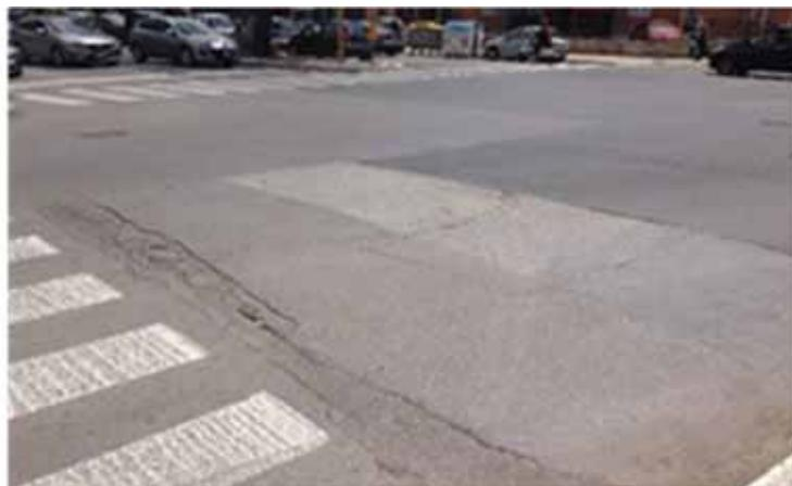
Fig. 6.50: Deformazioni della pavimentazione nel quadrante Nord.
