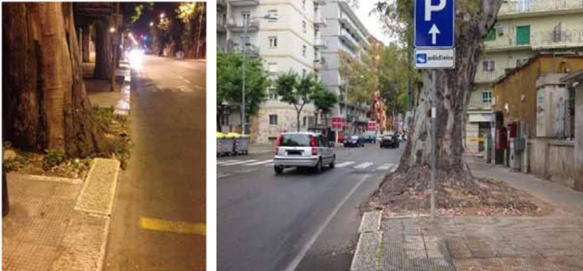
Fig. 6.46: Presenza delle radici sulla banchina di Viale Orazio Flacco (vicino all'intersezione con Via Storelli).
