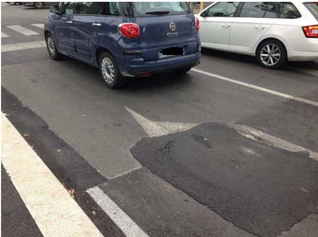
*Fig. 6.45: Ammaloramento della pavimentazione in corrispondenza della svolta a sinistra su Viale Papa Giovanni XXIII, prima dell'intersezione con Viale O. Flacco.*
