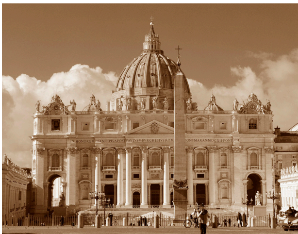
Fig. 9. Stato attuale della facciata di San Pietro (foto Marco Carpiceci, febbraio 2021).
