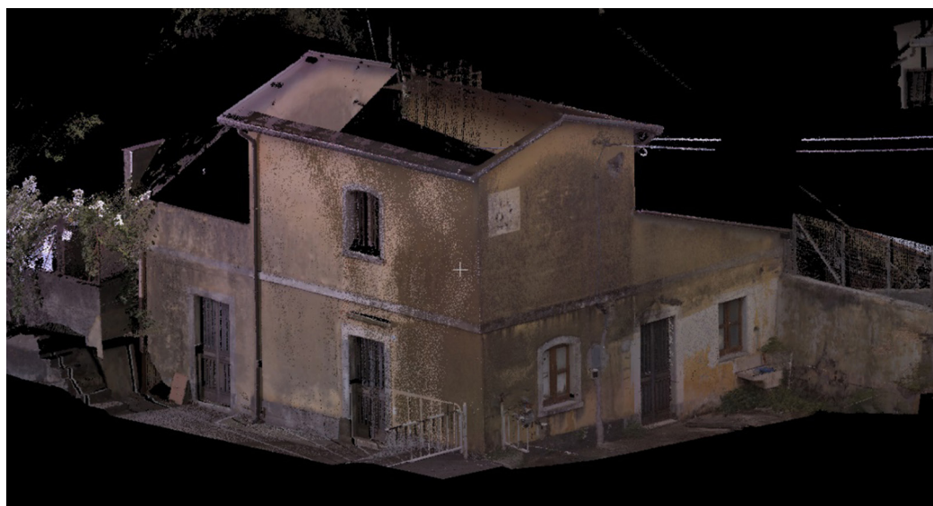
Fig. 12. La nuvola di punti del casello 92 ottenuta mediante rilievo laser scanner.
