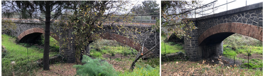
Fig. 5. Il ponte sul torrente Chiuse del Signore (foto di E. Salamone, 2021).
