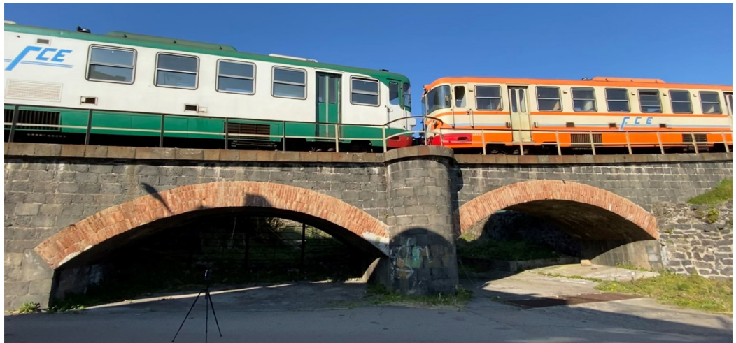
Fig. 4. Il ponte sul torrente Birbo nel momento del passaggio della Littorina, il treno della Circumetnea.
