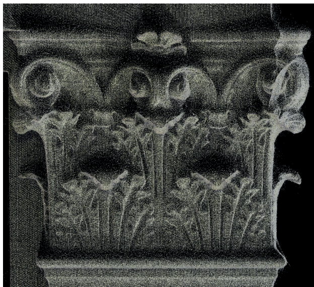
Fig. 4. Dettaglio da nuvola di punti di una parasta corinzia della Sagrestia, nonostante l'elevato dettaglio, a causa di oggetti e zone d'ombra non è possibile comprendere facilmente tutti i contorni che descrivono l'architettura.
