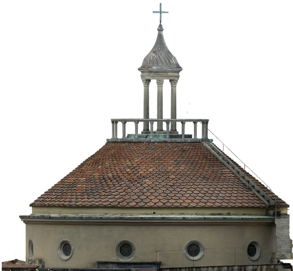
Fig. 8. Fotopiano dell'esterno della cupola della Sagrestia, dove è possibile vedere la singolare struttura con cupola di gusto arabeggiante posizionata sulla sommità (restauro di Sanpaolesi).
