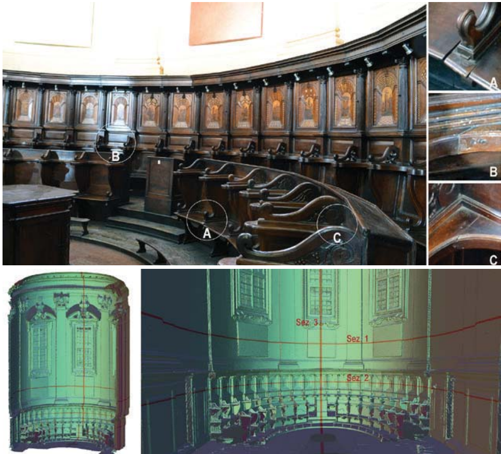
Fig. 5/ Immagine generale del coro con alcuni dettagli di innesto e taglio delle parti lignee.
