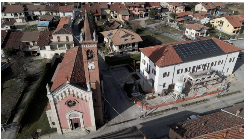
Figg. 5.5 e 5.6 - Impianto fotovoltaico del progetto EnergyCityHall, Comune di Magliano Alpi (CN). Fonte: CER EnergyCityHall, sito ufficiale ©
