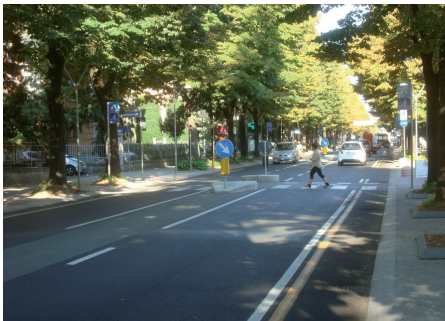
Fig. 2 - L'isola salvagente di via Emilia Ospizio a Reggio Emilia. Fonte: Foto di Matteo Donde
