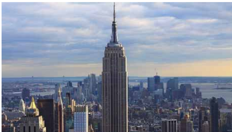
Figura 6 - L'Empire State Building, inaugurato nel 1931, tratto da la Repubblica, 26 febbraio 2021.
