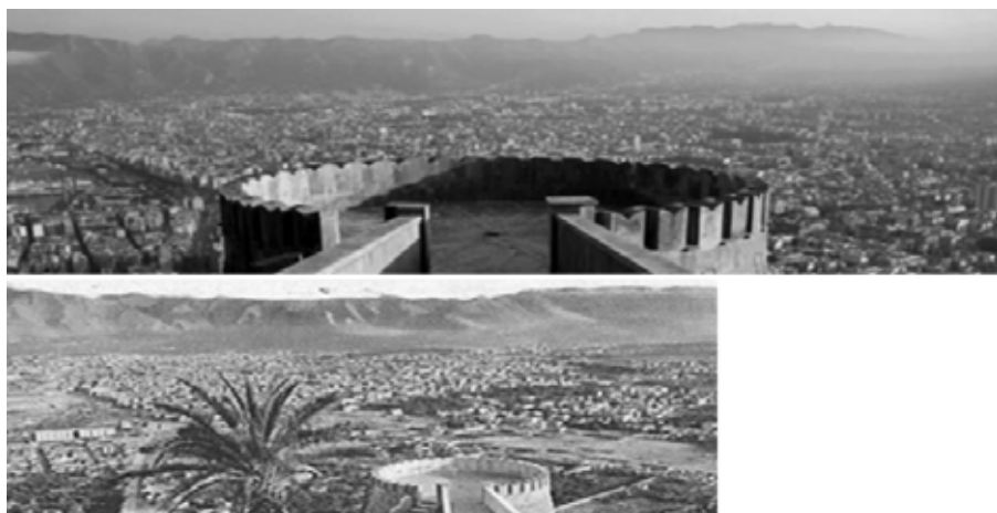
Figura 4 - Vista dall'alto di Palermo oggi e come era da una cartolina degli anni '40. Si ha un'idea della quantità enorme di edifici realizzati nell'arco di una ventina d'anni, durante gli anni '60 e '70, periodo del boom edilizio a Palermo durante il quale si sono realizzati quasi tutti gli edifici residenziali oggi esistenti.
