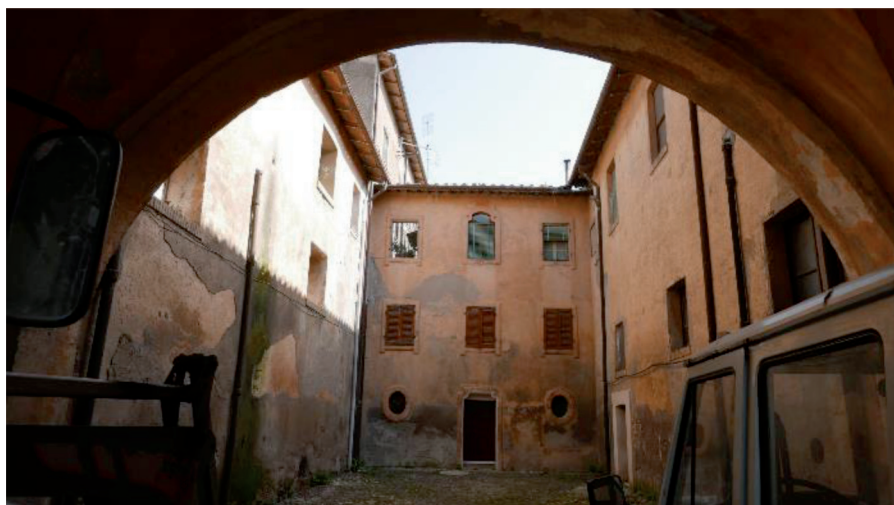
Fig. 6 – Casale di Castel di Guido, corte interna (foto G. Ortolani)
