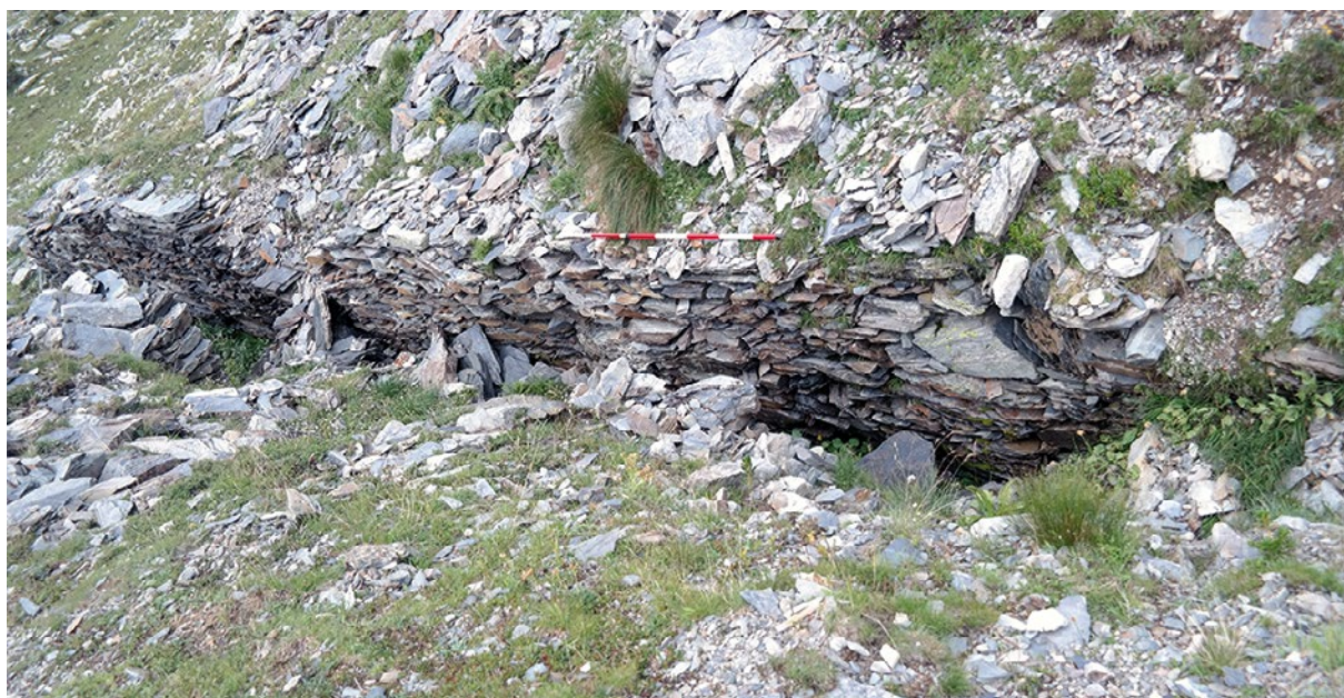
Figura 13. Piateda. Complesso minerario di Venina. Particolare del muro settentrionale del corridoio di accesso alla miniera (foto Ilaria Sanmartino).
