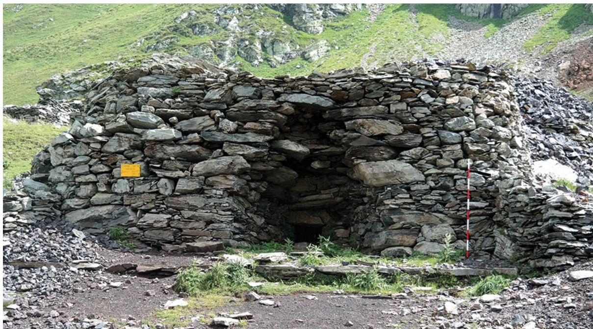
Figura 17. Piateda. Complesso minerario di Venina. Vista frontale del grande forno di arrostitimento: al centro l'apertura ricavata per l'estrazione del minerale (foto Ilaria Sanmartino).
