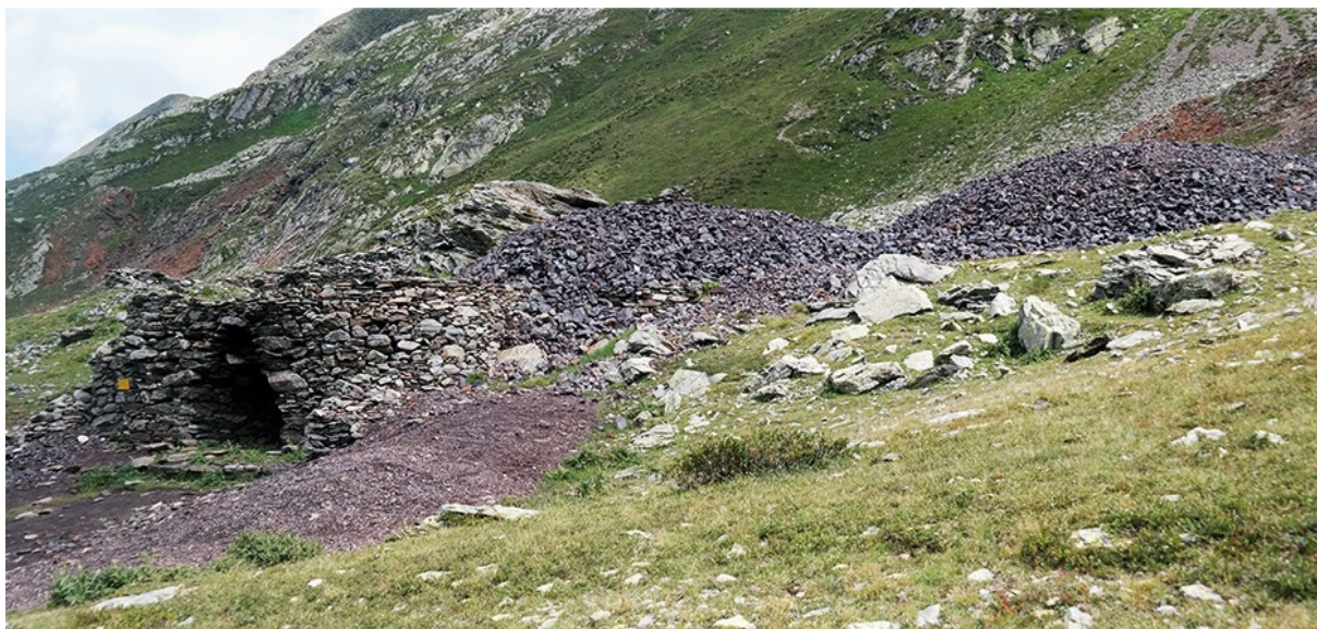
Figura 18. Piateda. Complesso minerario di Venina. Vista laterale della fornace (foto Ilaria Sanmartino).
