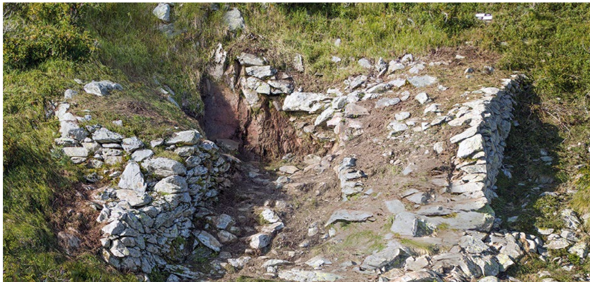
Figura 11. Fusine. Val Cervia. Forno di arrostimento a Sud della miniera. Vista prospettica della fornace (foto Ilaria Sanmartino).
