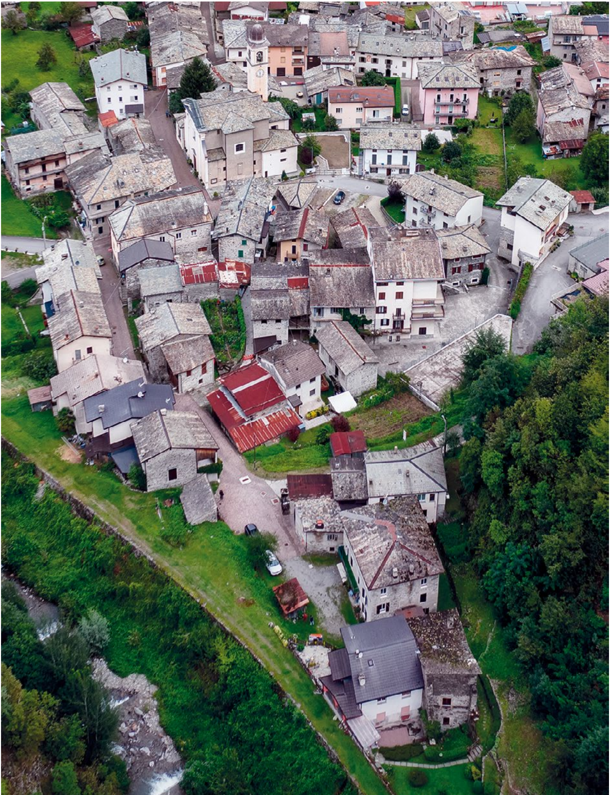
Figura 3. Cedrasco, il nucleo storico. La vista dall'alto mostra chiaramente la struttura dell'antico abitato edificato ai lati della Rùlgia, dove sono ancora conservati edifici solariati, dotati di pòrtech passanti (foto Luca Cornago).
