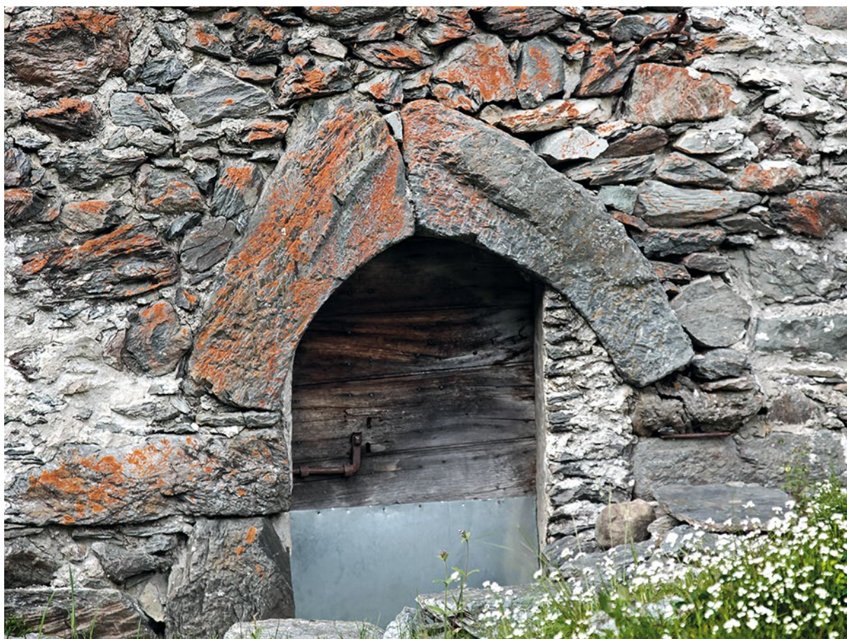
Figura 2. Ambria, comune di Piateda. Nel paesaggio del ferro, nella stratigrafia degli elevati, compaiono blocchi litici con evidenti tracce di siderite. Ad Ambria l'architrave monumentale e i conci utilizzati per la costruzione dell'edificio evidenziano la natura geologica del luogo e determinano una forte integrazione tra paesaggio naturale e paesaggio antropico (foto Marino Amonini).
