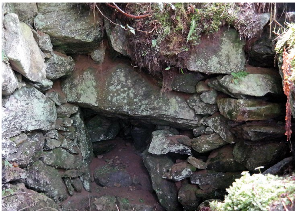
Figure 24. Piateda. Località “Li gèeri”. Forno di arrostitimento sepolto dalla vegetazione invasiva spontanea: particolare dell’apertura basale per lo scarico del minerale (foto Ilaria Sanmartino).
