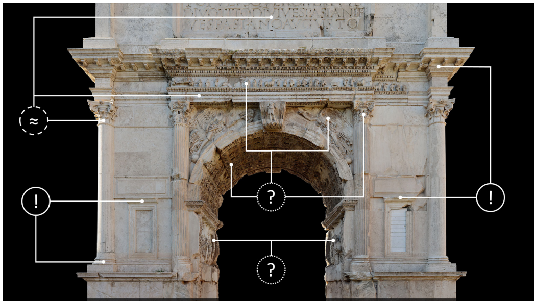
Fig. 01. L' Arco di Tito, al Foro Romano, è un notevole esempio di compresenza di partizioni architettoniche descrivibili (!), parzialmente descrivibili (≈) e non descrivibili (?) in forma geometrica.
