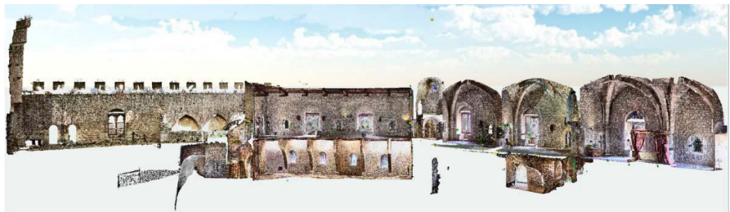
Fig. 09. Spaccato della scansione lungo la corte, della sala dei baroni con la sottostante sala d'armi, delle sale sveve con le crociere. (Immagine dell'autore).
