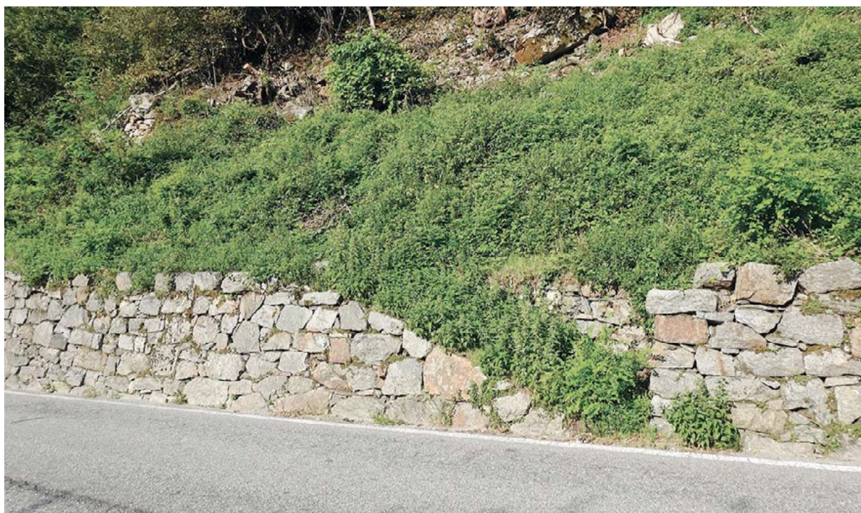
Figura 45. Scala di accesso ai terrazzamenti in località Gualtieri. Una ricca flora nitrofila ha ricoperto completamente le pietre della scala.
