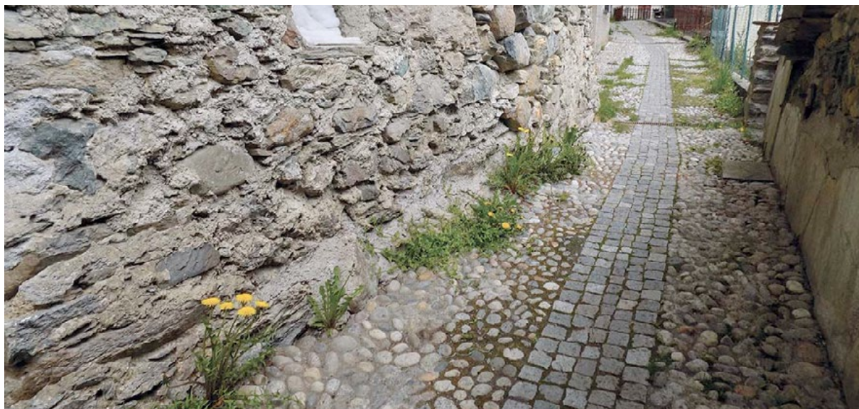
Figura 15. Strada interna a Primolo pavimentata in ciottoli con striscia centrale in cubetti di serpentinoscisto. La vegetazione dai bordi, dove minore è la pressione da caelestio, si protende verso il centro della via.
