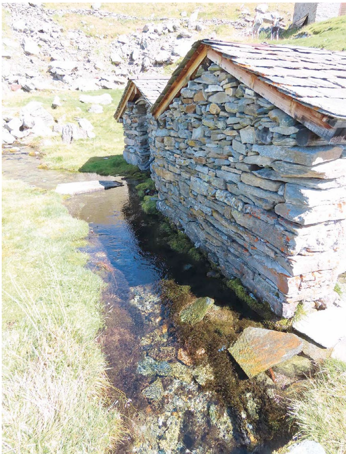
Figura 4. Malghe da alpeggio in prossimità delle precedenti. Si noti il manto del tetto, decisamente più sottile, realizzato in tempi più recenti con serpentinoscisto da cava.
