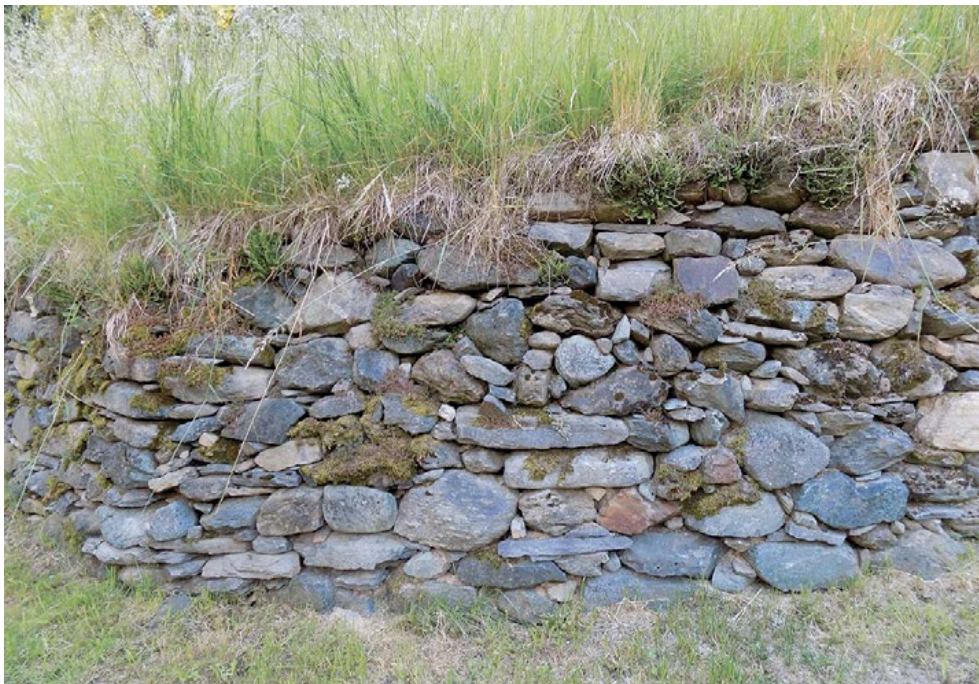
Figura 10. Muro di sostegno di un terrazzamento tra Melirola e Cristini.
