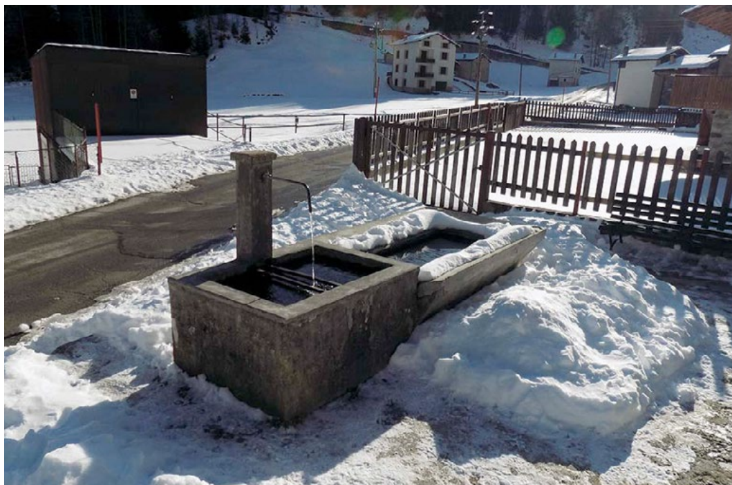
Figura 73. Una fontana di recente costruzione e l'attiguo lavatoio in struttura di cemento in località Francisa.
