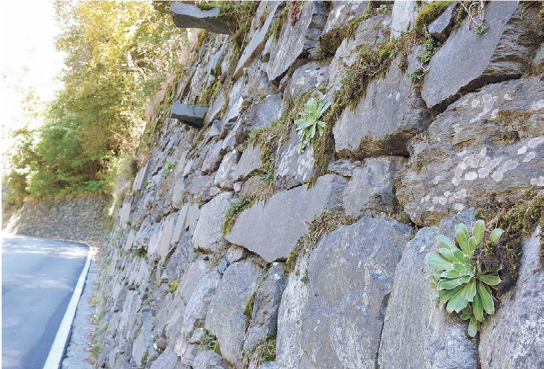
Figura 55. Muro di sostegno del versante a difesa della strada provinciale n. 15, al km 11, colonizzata da essenze rupicole di quota.
