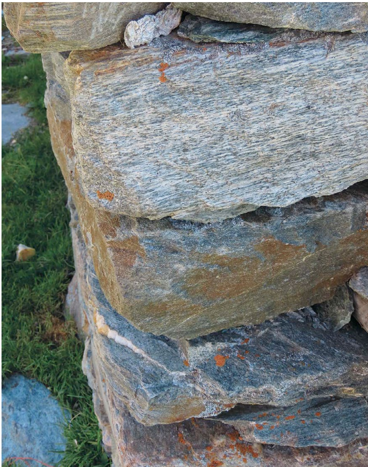
Figura 1. Elementi da muratura di una costruzione rurale ad uso abitativo. Si noti la varietà litologica, ogni elemento infatti è costituito da rocce diverse: serpentinite, anfibolite, orto-gneiss. Il fattore comune è l'orientazione planare prevalente che guida lo spacco naturale lungo le due facce parallele al suolo e che facilita l'operazione di impilamento degli elementi e di costruzione della muratura.
