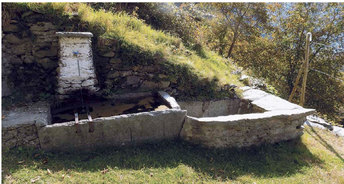
Figura 66. I lavatoi erano spesso abbinati ad una fontana di cui utilizzavano l'acqua di scolo. Un esempio è il lavatoio a Bedoglio con piani inclinati in pietra. Il muro su cui si appoggiano la fontana e il lavatoio ospita un'interessante flora rupicola.
