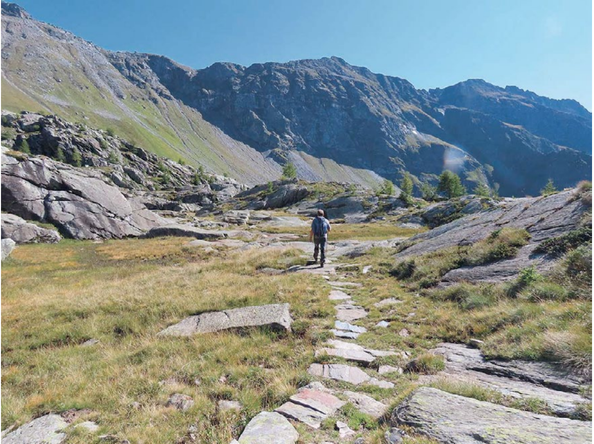
Figura 6. Un altro esempio di utilizzo delle grandi pietre piatte: pavimentazione di un sentiero in area soggetta ad accumulo d'acqua.
