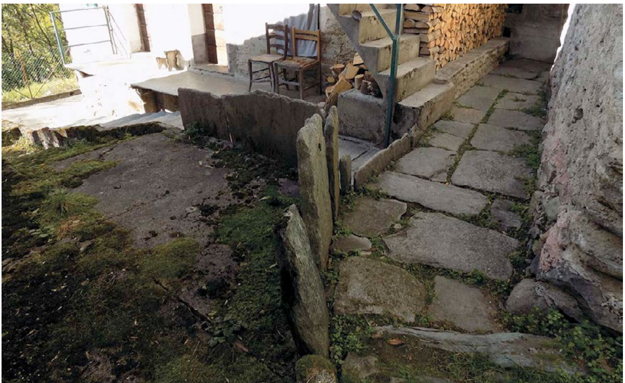
Figura 25. Lastre in pietra in verticale delimitano proprietà e passaggi pedonali all'interno del centro abitato di Scaia.
