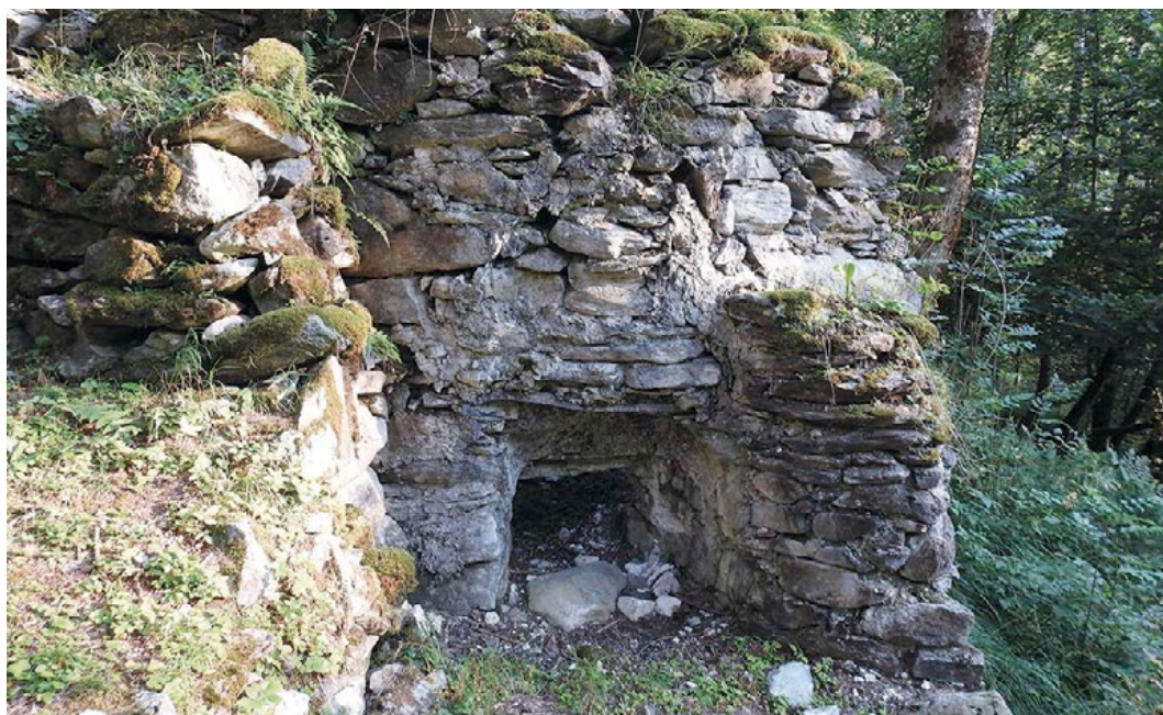
Figura 67. La bocca della seconda calchera per il caricamento della legna e l'alimentazione del fuoco.
