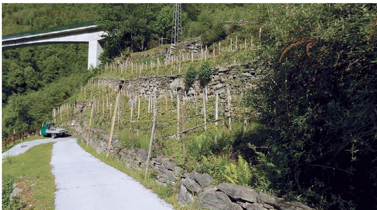
Figura 5. La strada scorreva tra terrazzamenti coltivati a vite di cui sono rimasti pochi esempi ed è protetta a monte da un muretto a secco che ospita un consorzio vegetale particolare.
