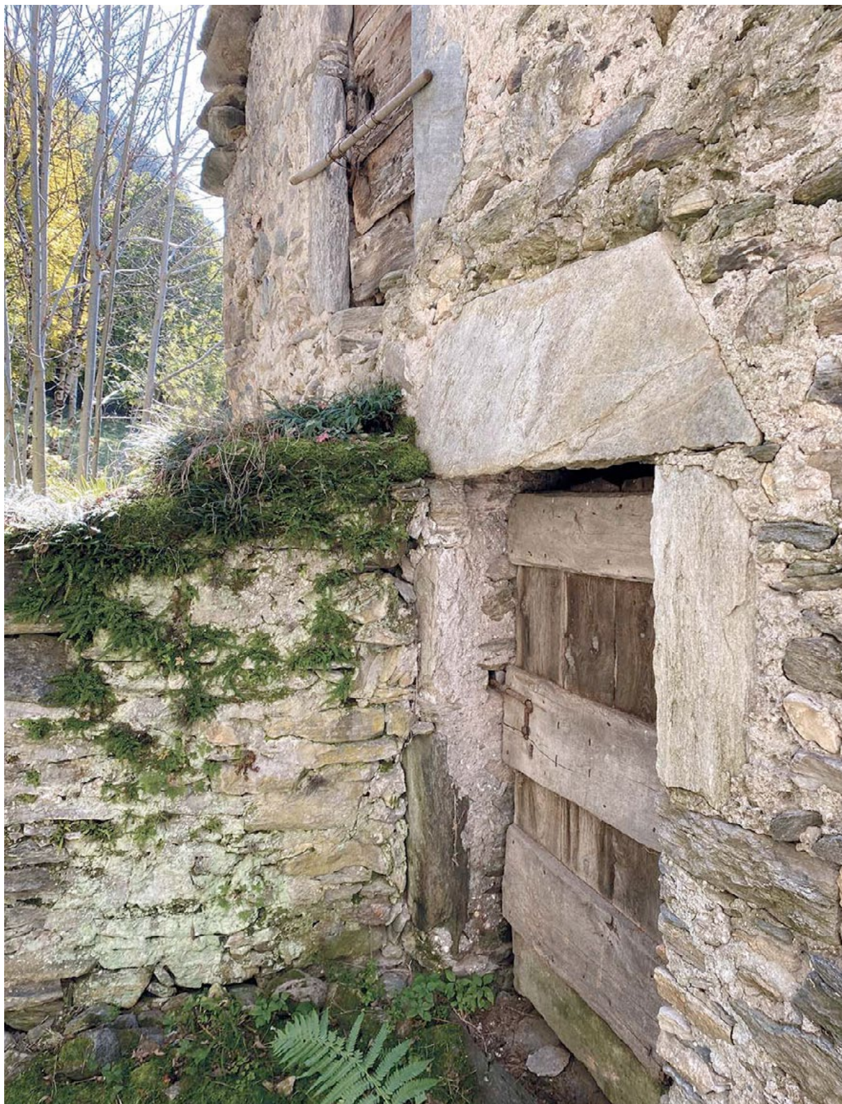
Figura 14. Elementi monolitici in gneiss massiccio, sagomati in parallelepipedi a misura, con sezione trapezoidale e utilizzati al contorno di un ingresso a Melirolò.
