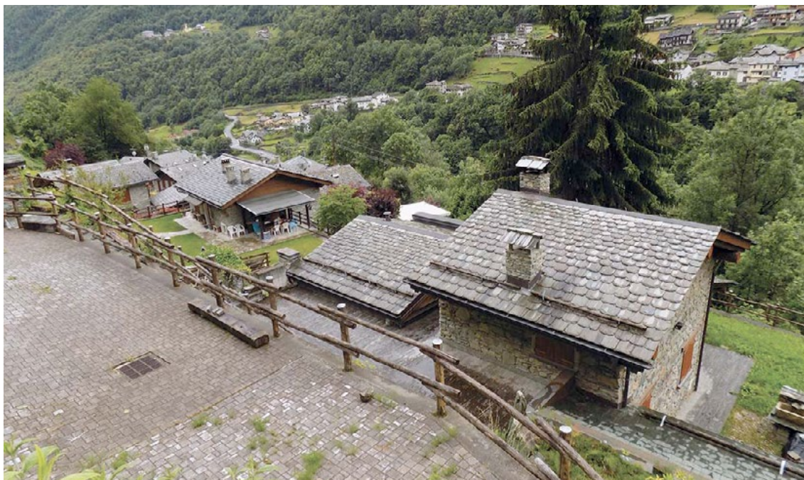
Figura 32. Tetti in Piode della nuova urbanizzazione lungo la strada per Cagni. L'uguaglianza delle pezzature delle piastre e la regolarità della posa, pur nella loro armonia, rendono tutte le coperture simili tra di loro.
