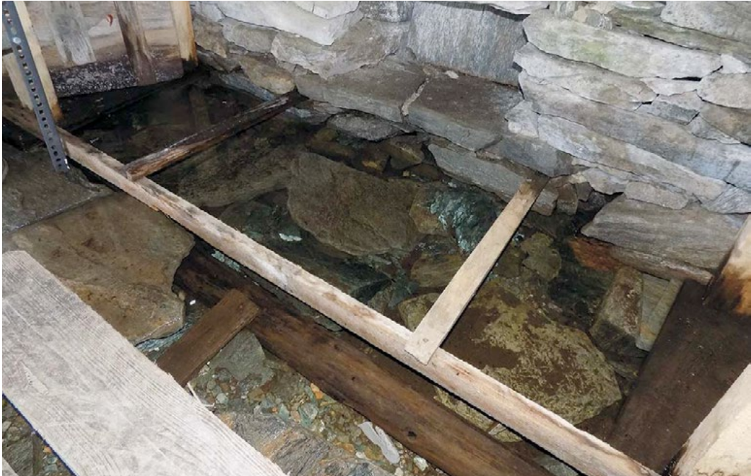
Figura 47. All'interno del casello del latte, l'acqua scorre lentamente su tutto il pavimento raffreddando l'intero ambiente.
