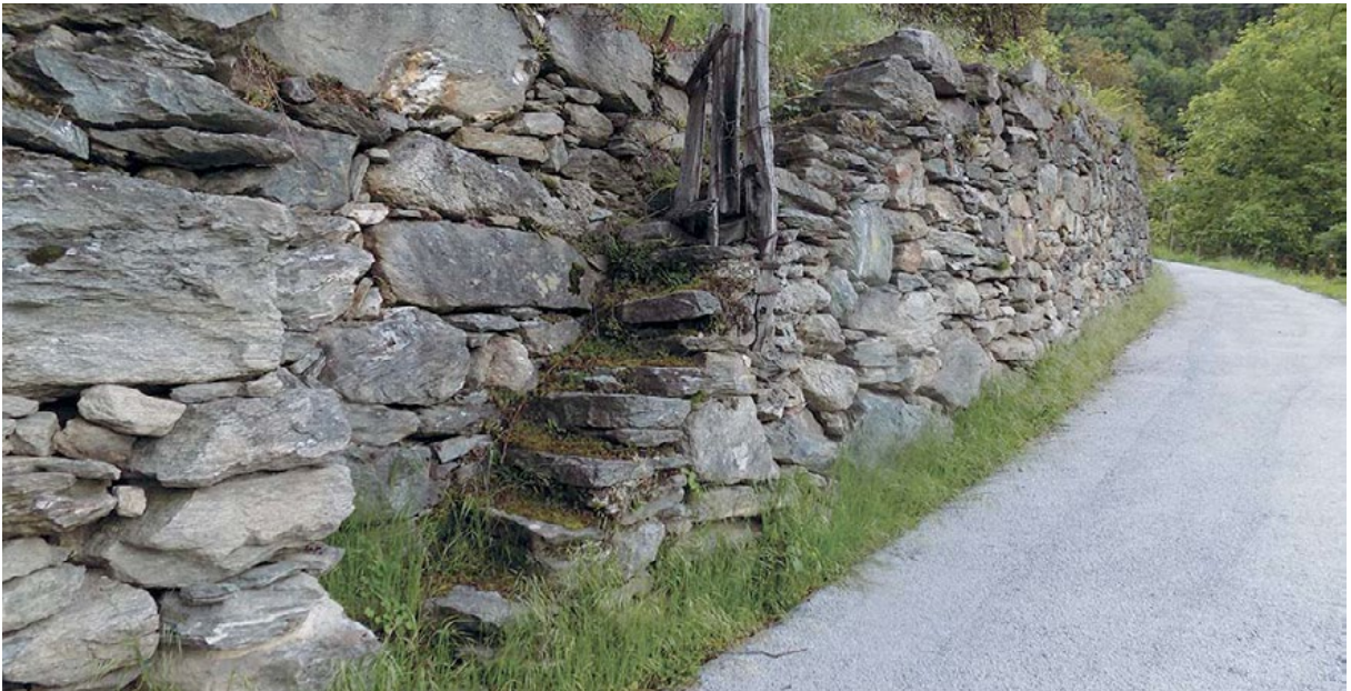
Figura 40. Le scale di accesso e di collegamento tra i poderi sono eseguite con massicci blocchi unitari e corrono parallele alle cortine murarie, come in questo accesso ad un terrazzamento sopra Arquino.
