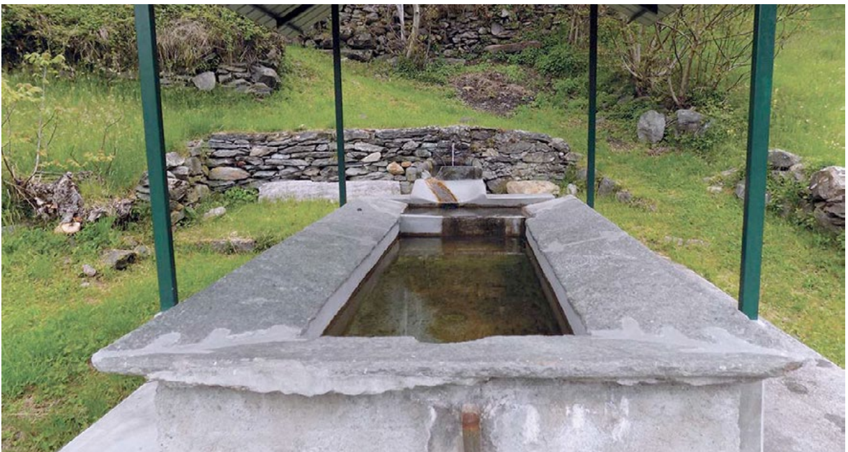
Figura 68. Lavatoio con piani inclinati in pietra al riparo di una tettoia a Cagnoletti.
