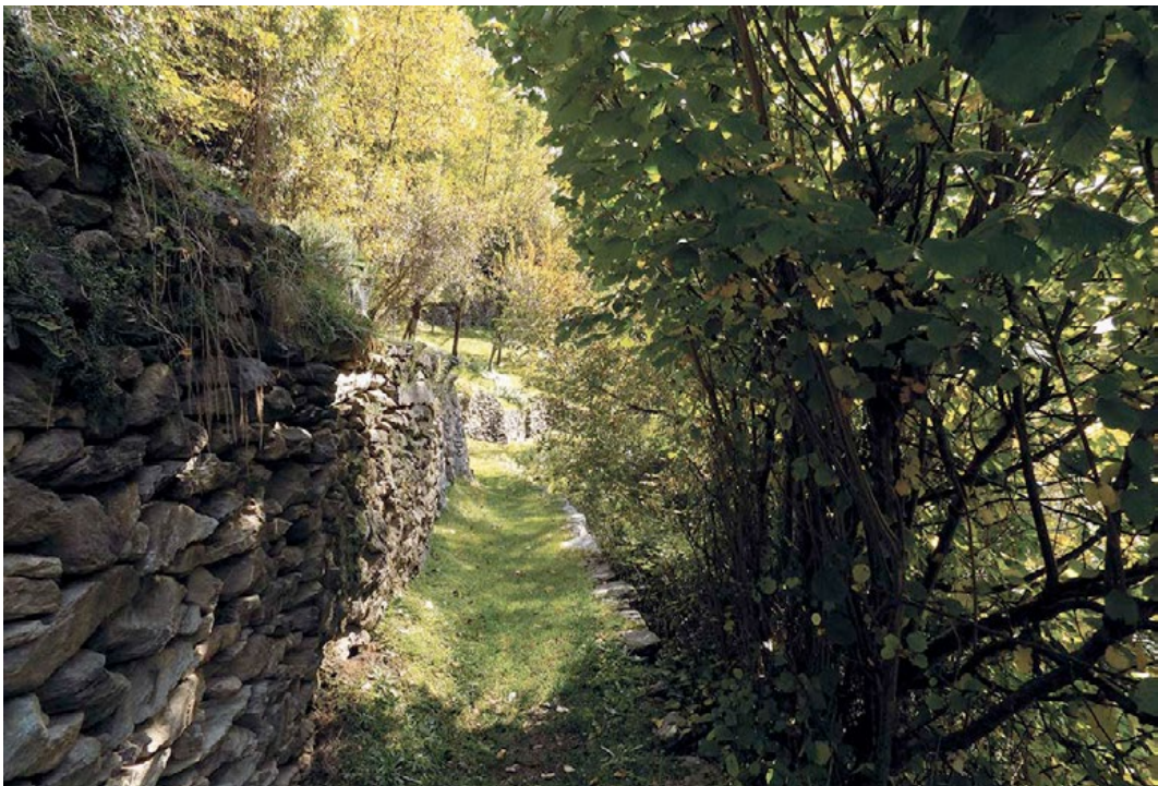
Figura 10. Mulattiera alle porte di Bedoglio. La strada è sostenuta da un muretto a valle e difesa a monte da un alto muro che sorregge un terrazzamento.
