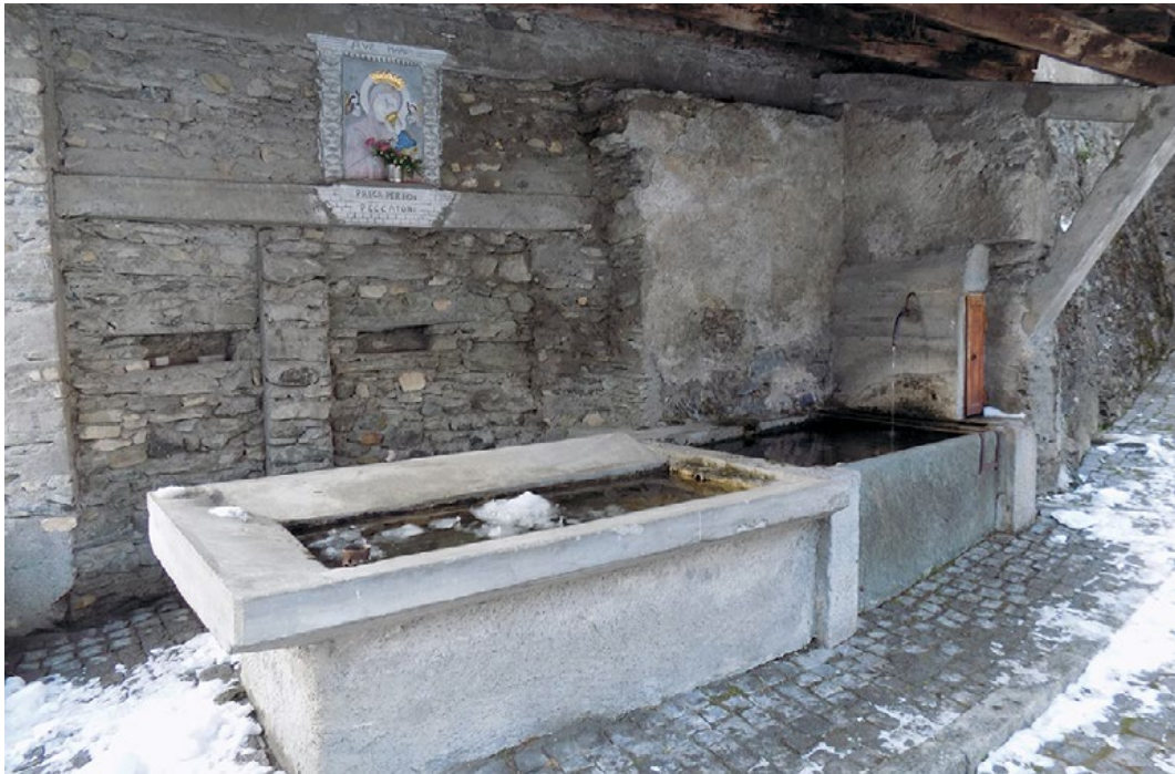
Figura 55. Fontana con la vasca in pietra a Tornadri, abbinata ad un lavatoio di recente costruzione in cemento.
