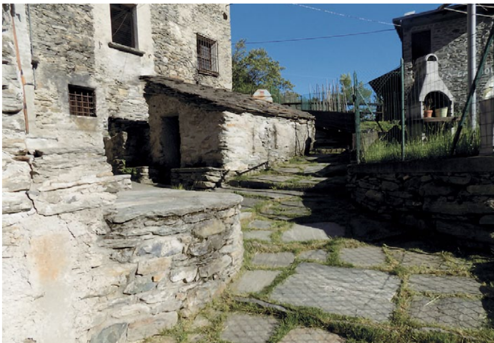
Figura 12. Piccola corte a Cristini, che sintetizza le principali possibilità di utilizzo delle piöde : per copertura dei tetti, per pavimentazione, per i sedili fuor dall'uscio, per le pedate delle scale e i piani dei davanzali.
