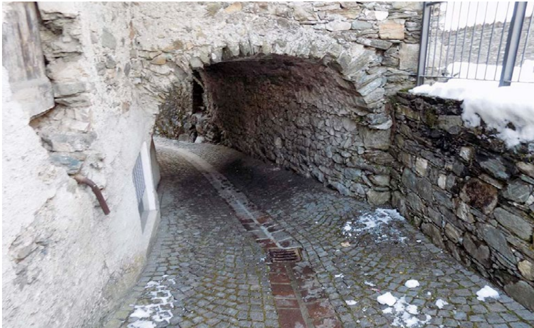
Figura 26. Strada lastricata con cubetti di serpentinoscisto a Tornadri.
