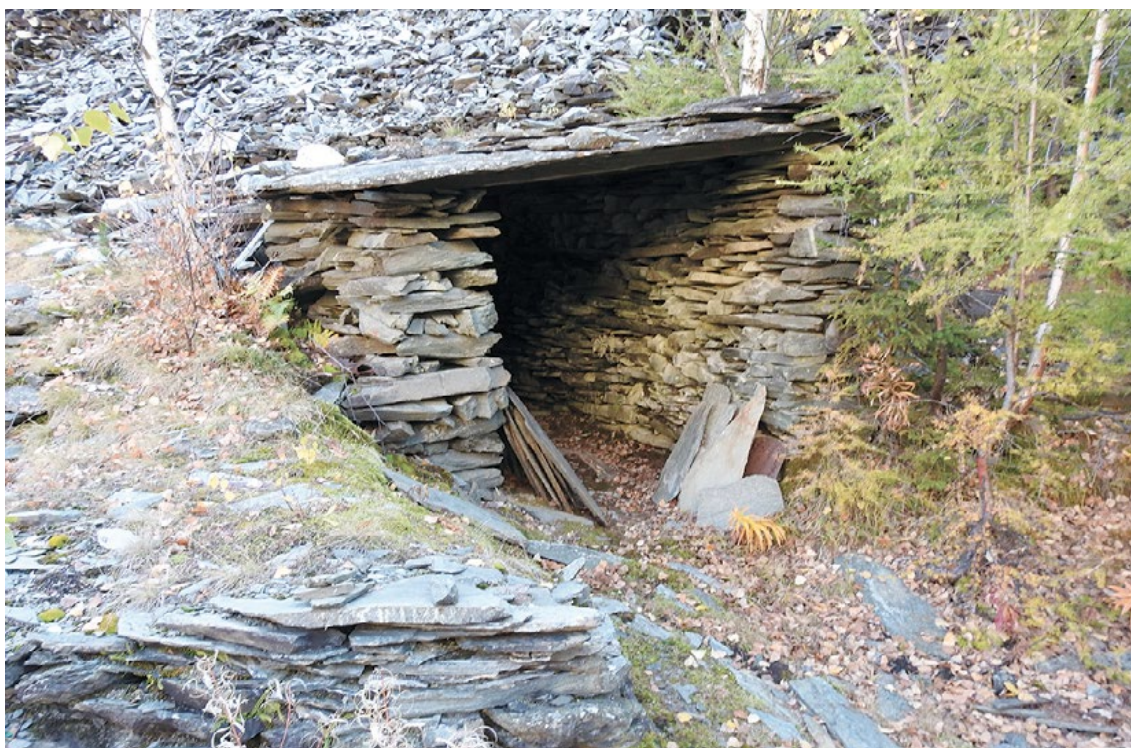
Figura 91. Ingresso di una miniera abbandonata al Giovello.
