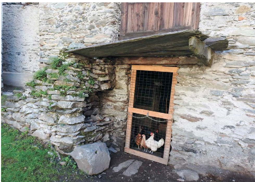
Figura 13. Vassalini, pianerottolo monolitico in serpentinoscisto. Da notare la dimensione della lastra, lo spessore, sottilissimo e la distanza tra i due montanti di supporto, possibile solo grazie alla straordinaria elasticità (resistenza alla flessione) del serpentinoscisto.
