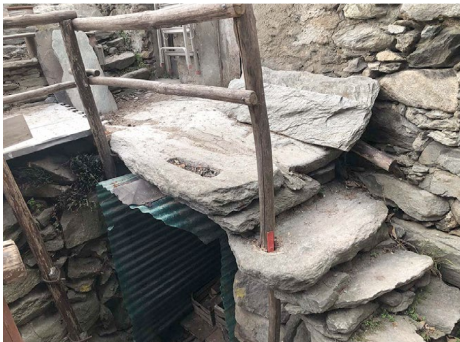
Figura 20. La depressione rettangolare, ora inutilizzata e perciò piena di foglie, su una lastra “pianerottolo” a Scilironi con la funzione di abbeveratoio per le galline di un pollaio “sospeso”.
