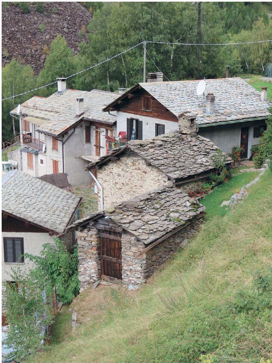
Figura 7. La “monocoltura minerale” dei tetti in pietra della Valmalenco, in un piccolo agglomerato di case con il manto di copertura dei tetti dal tipico aspetto a squame. Si notino i tetti più recenti, in serpentinoscisto, a bassissimo spessore, e quelli più antichi, più spessi e ancora performanti.
