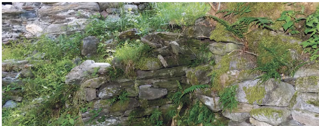
Figura 43. Muro di sostegno all'interno dell'abitato di Melirolò. La posizione riparata e umida consente la crescita di ben tre specie di felci: l'Asplenio tricomane, la Felcetta fragile e la Felce maschio.
