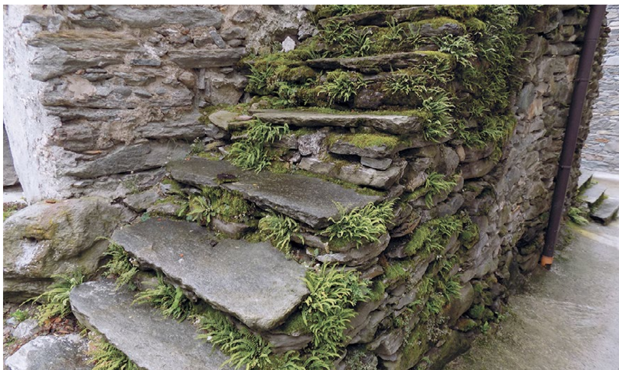
Figura 51. Le scale di accesso ai piani superiori sono di solito addossate alla parete dell'abitazione per non ostacolare il passaggio sulla strada. A Cristini una scala in pietra è arricchita dalla felce Asplenio tricomame .
