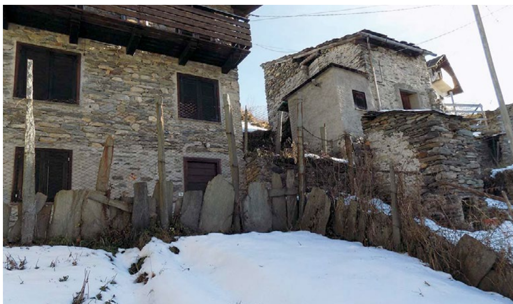
Figura 29. Recinzione di un orto a Pedrotti con pali di serpentinoscisto. Lungo il perimetro dell'orto sono state collocate in verticale lastre in pietra a protezione termica delle colture orticole.
