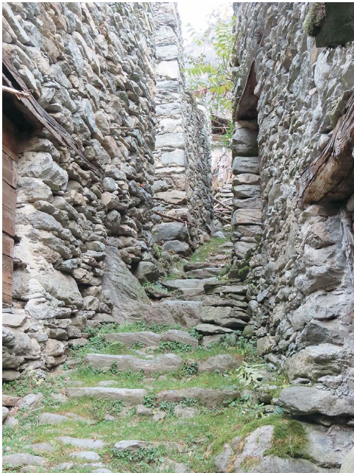
Figura 5. Scorcio dell'erto passaggio tra alcune abitazioni a Scilirioni. Si noti la continuità tra la geologia affiorante e la geologia costruita, e l'attento utilizzo della pietra, selezionata nella forma e dimensione degli elementi in base alla collocazione: conci d'angolo e al contorno delle aperture, più grandi e sagomati, elementi generici da muratura, gradini monolitici.
