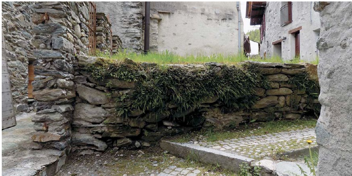
Figura 39. Muro in pietra a secco a sostegno di uno slargo a Primolo, ricoperto dalla piccola felce Asplenio tricomane .
