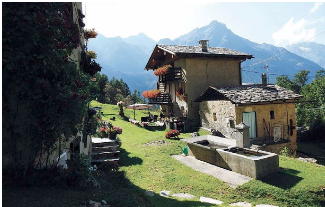
Figura 71. Fontana con lavatoio costruita in cemento presso il maggengo Prabello, sopra Caspoggio, divenuto ormai centro abitato di residenze estive.
