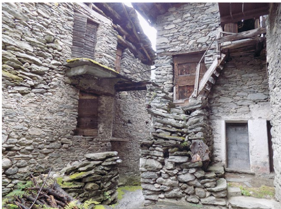
Figura 47. A Spriana due rampe di scale di accesso ai piani superiori di due abitazioni separate dalla strada hanno origine da un unico sostegno.
