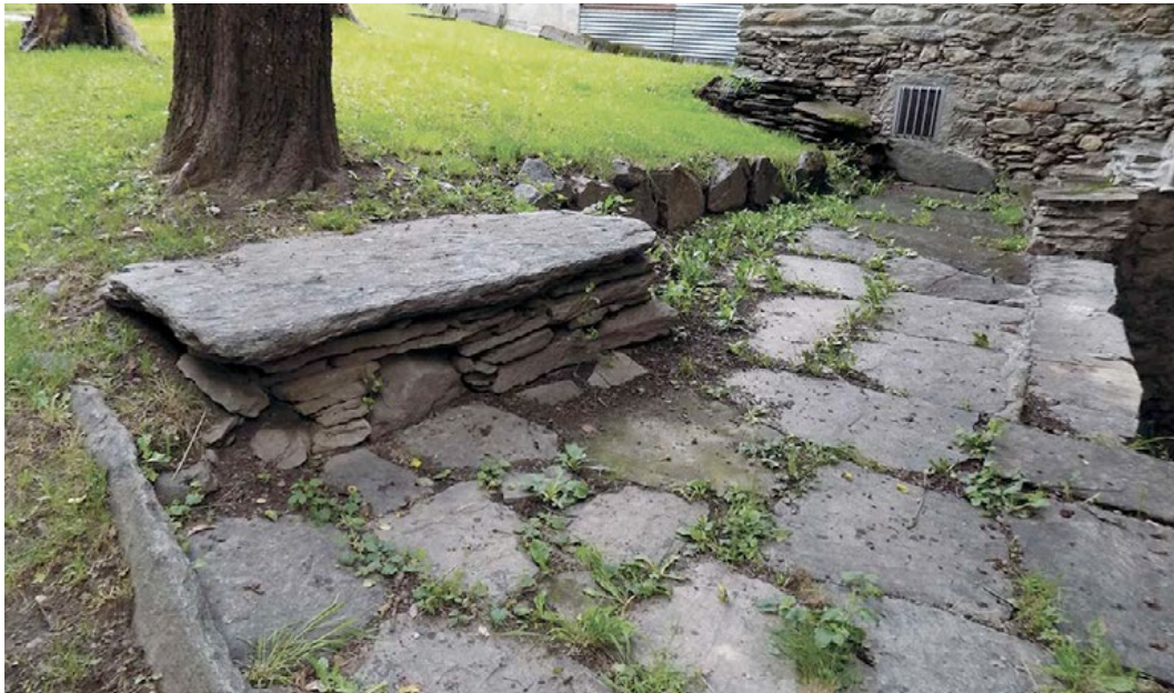
Figura 8. Piccola piazzetta in località Cristini pavimentata con lastre di serpentinoscisto. Nelle linee di fuga trovano spazio essenze tipiche dei calpestii.
