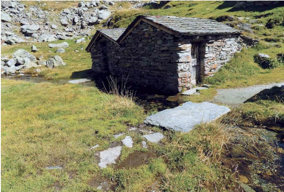
Figura 51. Una grossa lastra in pietra consente di attraversare il corso d'acqua presso due caselli del latte inondata all'Alpe Prabello.
