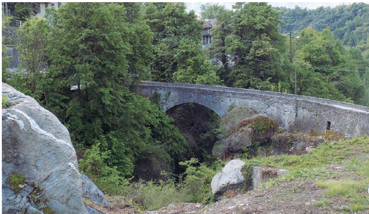
Figura 46. Il ponte in pietra ad arco sul Mallero ad Arquino.
