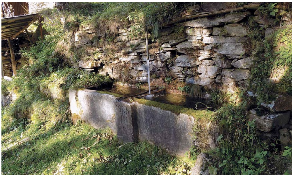
Figura 61. La fontana a Gianni è addossata alla parete costruita in blocchi di pietra a sostegno del pendio. Un complesso consorzio vegetale circonda l'intera fontana.
