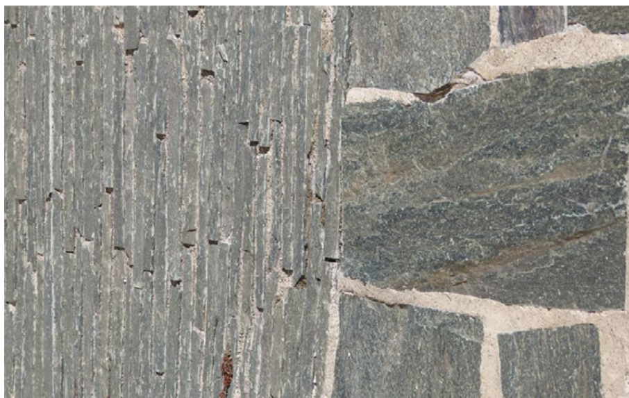
Figura 10. Sagrato della chiesa di Torre Santa Maria: pavimentazione contemporanea realizzata con lastre di serpentinoscisto. Particolare del raccordo tra la pavimentazione del sagrato, in piano, e la strada di accesso al percorso pedonale, in discesa. Data la forte acclività del percorso, la pietra è stata posata a coltello (come se fosse in smolleri di porfido), mettendo in evidenza la sezione scistosa della pietra, che così offre una maggiore resistenza allo scivolamento. Sono ben visibili gli allineamenti planari dei minerali lamellari.
