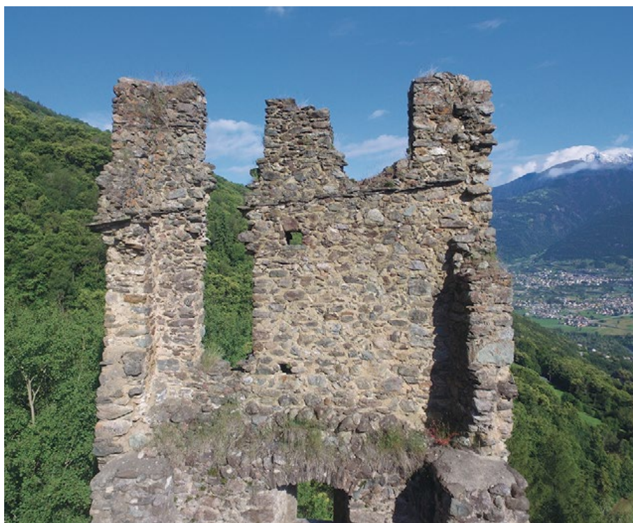
Figura 7. La linea di gronda visibile all'ultimo livello della torre.
