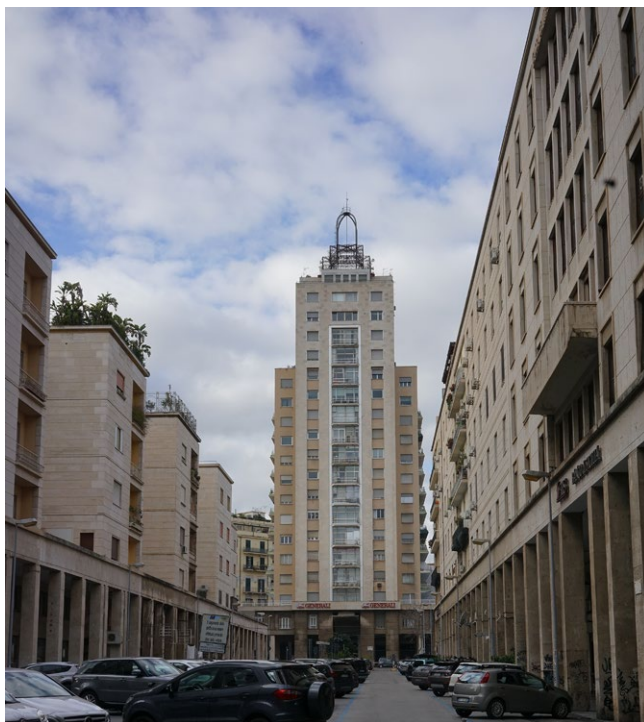
Fig. 1/ Piazzale Ungheria, Palermo. Foto del grattacielo che chiude uno dei lati del piazzale, di forma rettangolare allungata.
