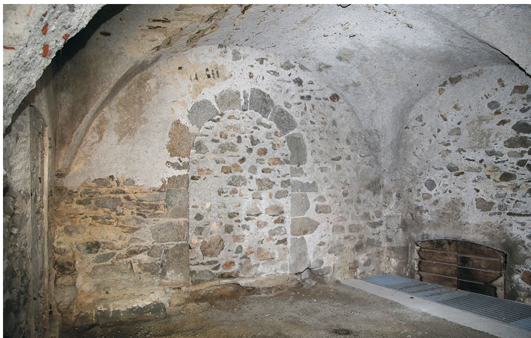
Figura 42 Ponte, incrocio tra via Giuseppe Piazzi e via dell'Asilo. Andito al piano terreno con portone tamponato sul prospetto Est del palazzo di via Piazzi, 12 (foto Marquis).
