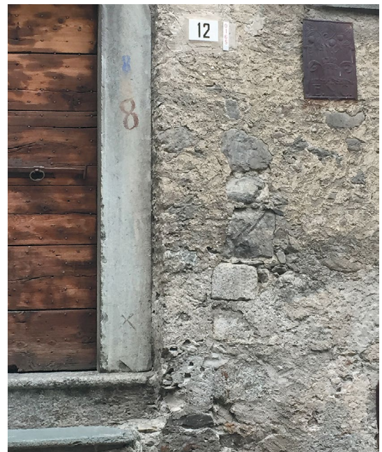
Figura 4. Ponte, via Giuseppe Piazzi, 12. Tracce di spalla a grossi conci alla destra del portale cinquecentesco (foto Francesca Bormetti).
