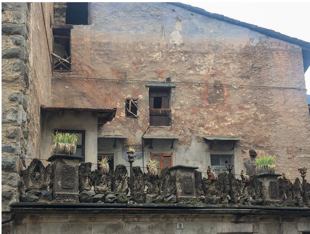
Figura 43 Ponte, prospetto verso via Piazzi dell'edificio con ingresso in via dell'Asilo. Si intravede la decorazione ad affresco della parete a fingere una costruzione tardomedievale, con profilo merlato, finestre centinate e scala esterna d'accesso al punto di passaggio tra il palazzo di via Piazzi, 12 e la struttura di accesso alla casa torre (foto Francesca Bormetti).
