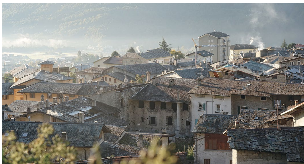
Figura 6. Casa torre (foto Claudio Franchetti).
