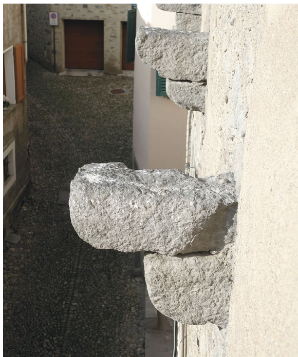
Figura 17. Ponte, via Giuseppe Piazzi, 12. Beccatelli sulla facciata verso strada tra secondo e terzo piano (foto Francesca Bormetti).
