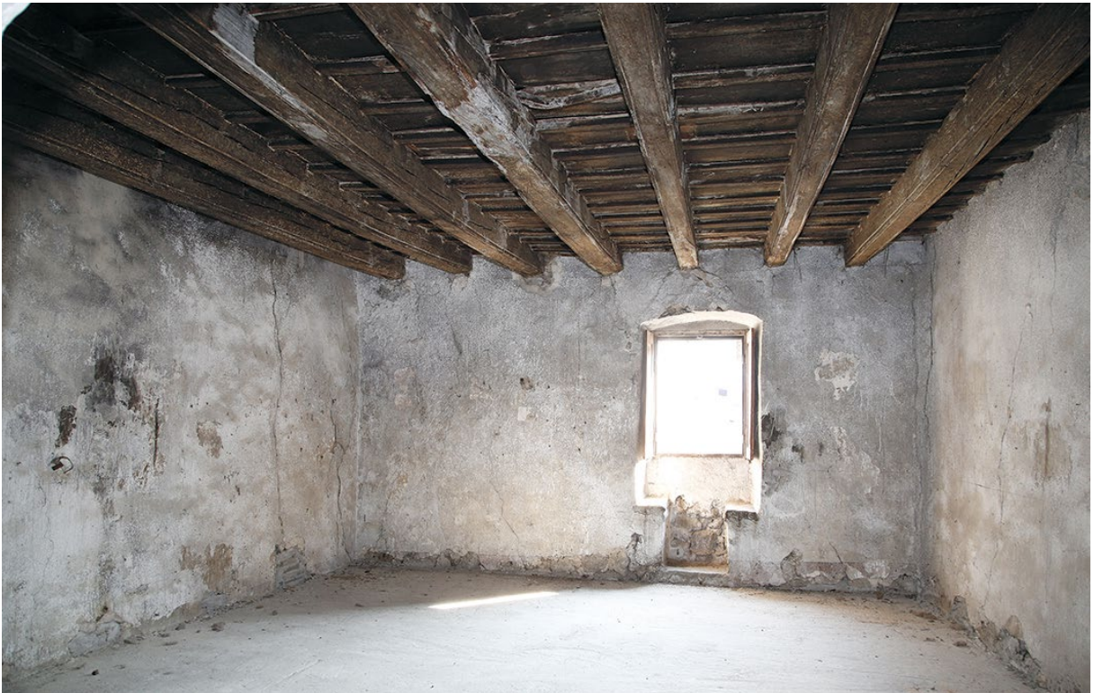
Figura 25. Ponte, via Giuseppe Piazza, 12. Secondo piano, seconda stanza, verso la facciata su strada (foto Francesca Bormetti).
