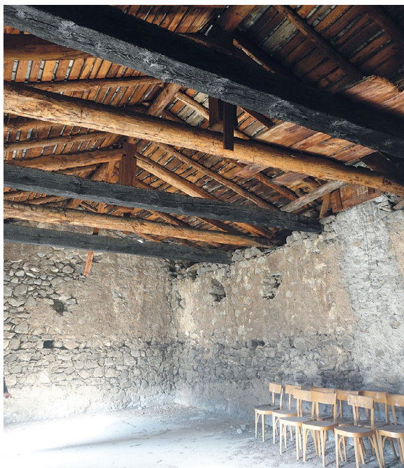
Figura 23. Ponte, via Giuseppe Piazzi, 12. Terzo piano del palazzo, copertura a capriate del grande ambiente (foto Francesca Bormetti).
