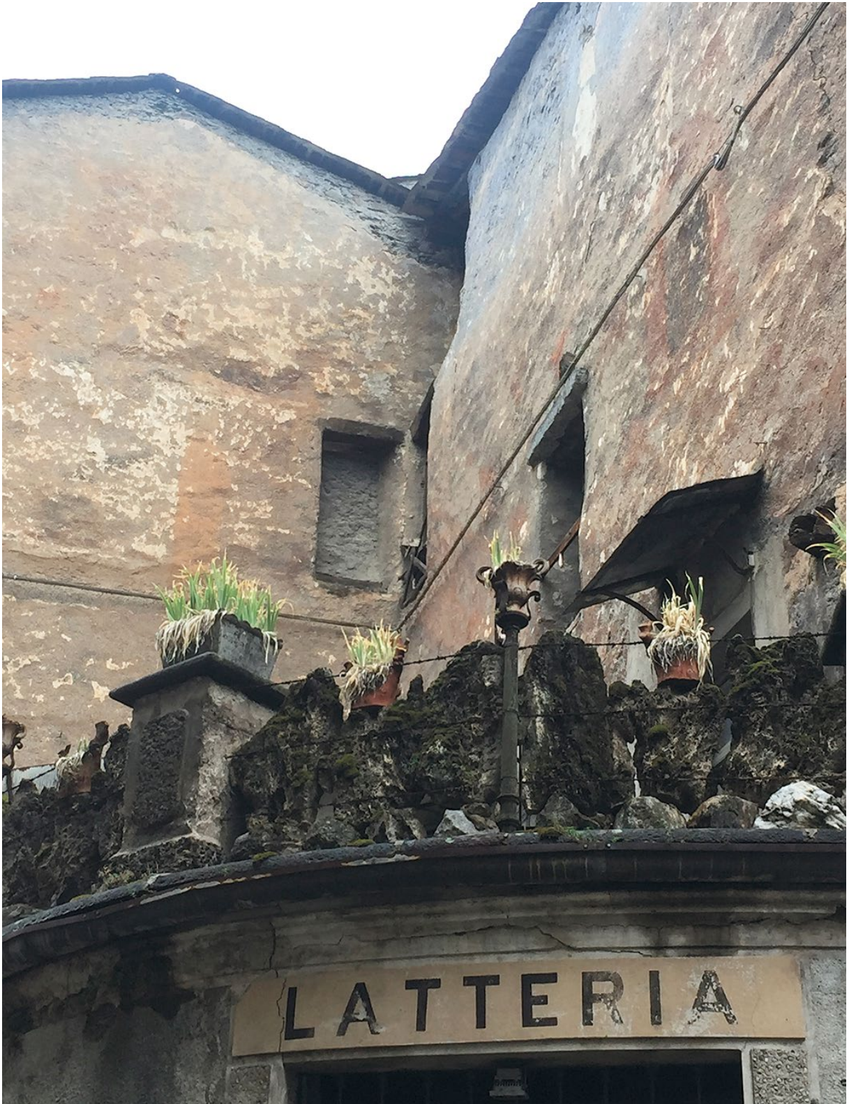
Figura 40. L'innesto verso strada del palazzo di via Piazzoli, 12 con l'edificio in via dell'Asilo, 1 (foto Francesca Bormetti).
