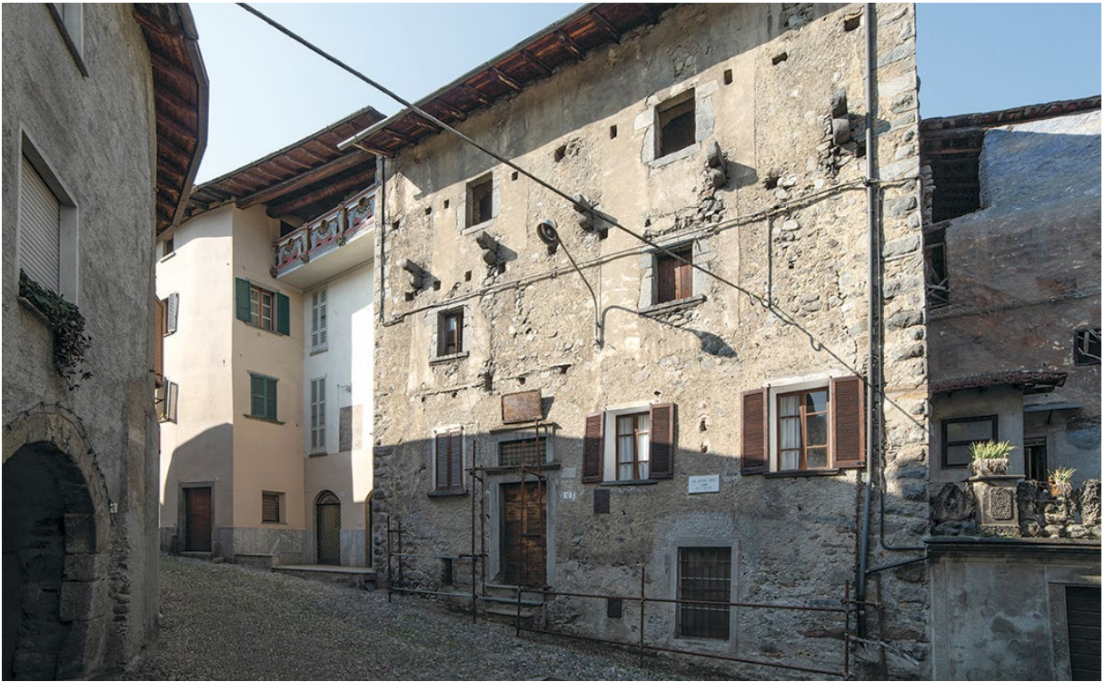
Figura 2. Ponte, via Giuseppe Piazzi, 12. Facciata (foto Marquis).
