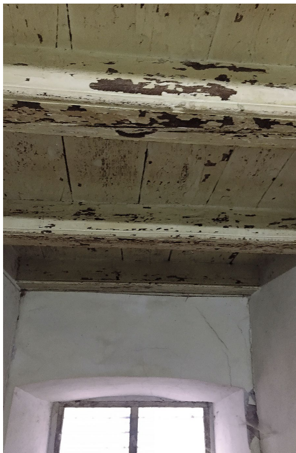
Figura 10. Ponte, via Giuseppe Piazzi, 12. Soffittatura lignea nell'andito d'ingresso (foto Francesca Bormetti).
