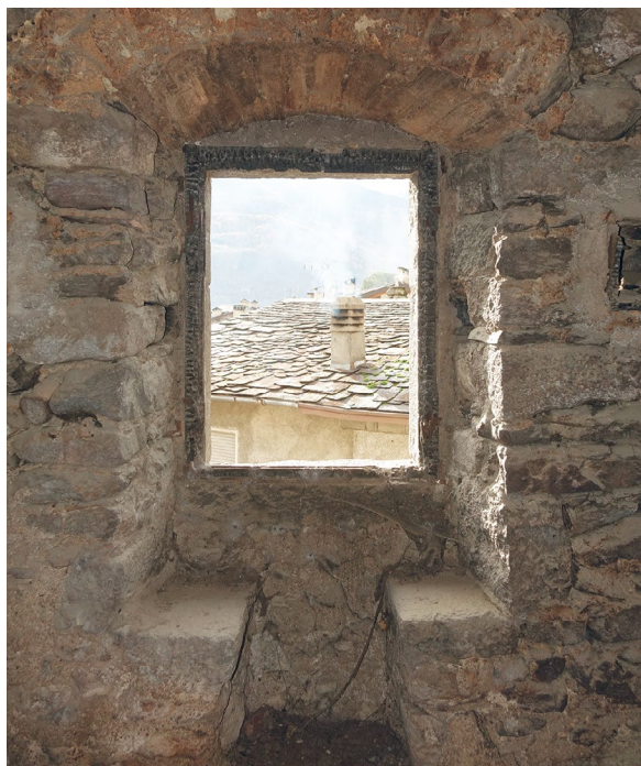
Figura 16. Ponte, via Giuseppe Piazzi, 12. Finestra al terzo piano, vista dall'interno con sedute laterali (foto Francesca Bormetti).
