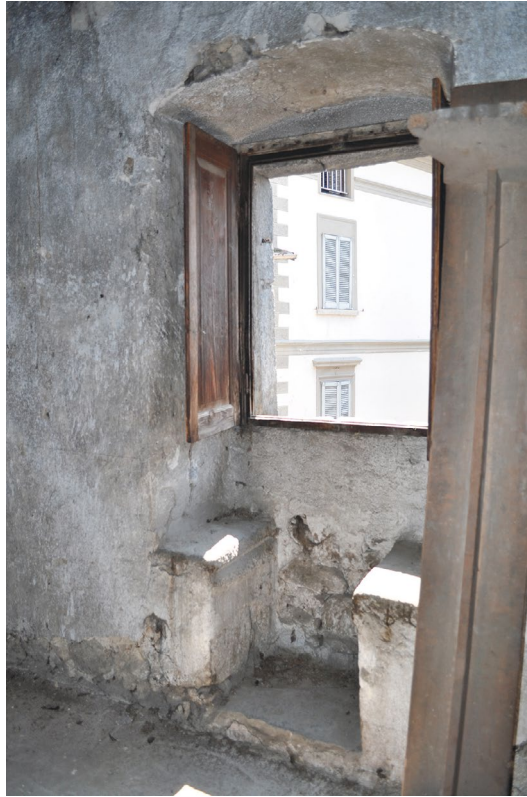
Figura 7. Casa della latteria, interno (foto Davide Borromeo).
