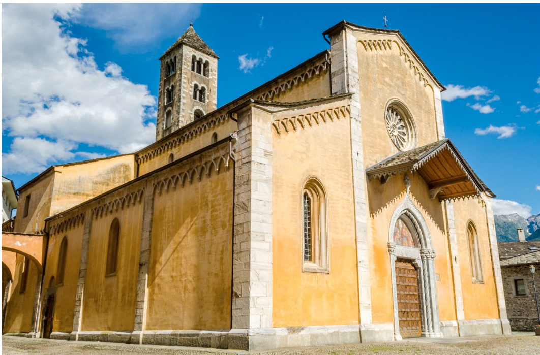
Figura 18b. Ponte, San Maurizio, veduta della facciata e del fianco settentrionale della chiesa (foto Armand K).
