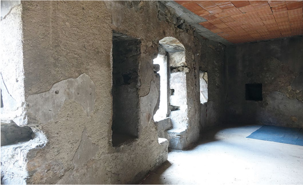
Figura 33. Ponte, via Giuseppe Piazzi, 12. Andito al secondo piano, verso Est (foto Francesca Bormetti).
