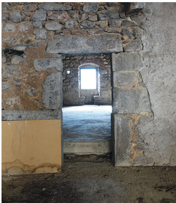
Figura 22. Ponte, via Giuseppe Piazzi, 12. Terzo piano del palazzo, porta di accesso dall'andito al grande ambiente verso strada (foto Francesca Bormetti).
