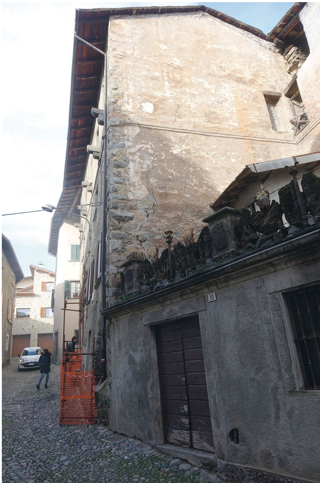
Figura 13. Ponte, via Giuseppe Piazzi, 12 e 10. Prospetto Est del palazzo e successivo edificio terrazzato, già ad uso della Latteria Sociale (foto Francesca Bormetti).
