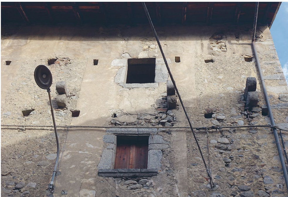
Figura 15. Ponte, via Giuseppe Piazza, 12. Finestre della facciata su strada, lato Est (foto Francesca Bormetti).
