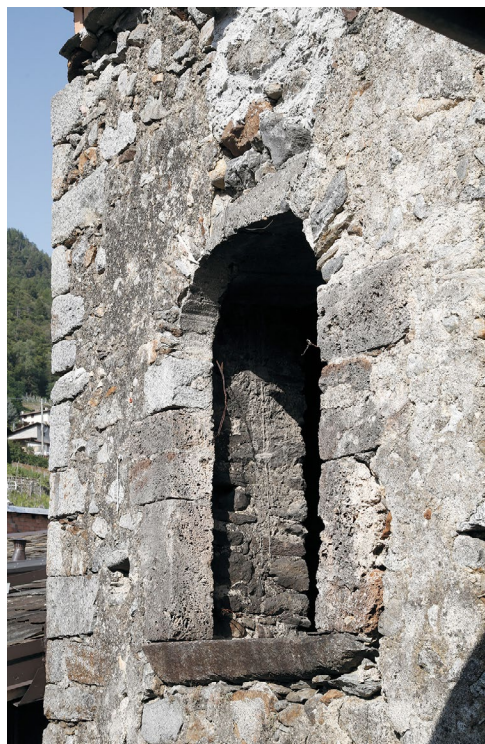
Figura 39. La finestra all'ultimo livello dell'edificio torre (foto Marquis).
