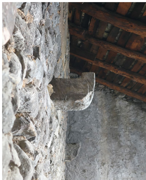
Figura 20. Ponte, via Giuseppe Piazzi, 12. Terzo piano del palazzo, facciata verso il cortile (prima fase edilizia), ora parete dell'andito (seconda fase), particolare dei beccatelli (foto Francesca Bormetti).
