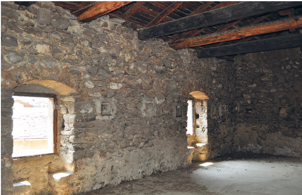
Figura 8. Casa della latteria, interno (foto Davide Borromeo).
