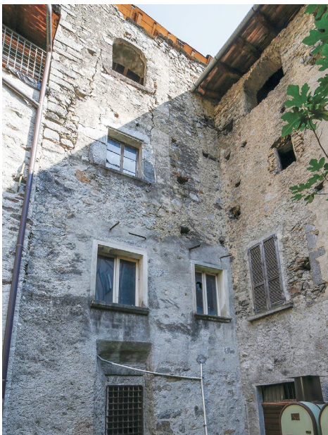
Figura 28. Ponte, via Giuseppe Piazzi, 12. Innesto verso il cortile dell'angolo Nord/Est del palazzo con la casa torre di via dell'Asilo (foto Marquis).
