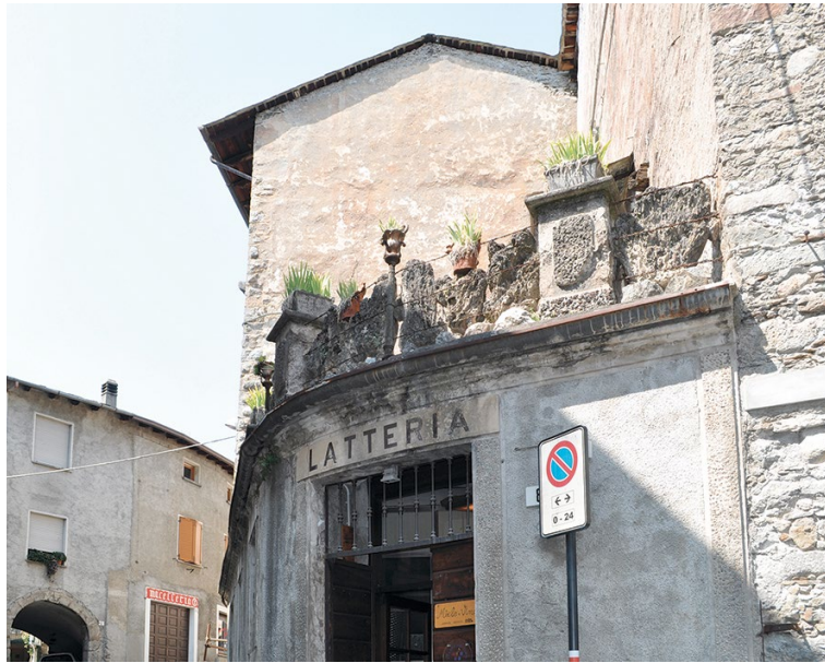
Figura 3. Ponte in Valtellina, la casa della latteria (foto Davide Borromeo).
