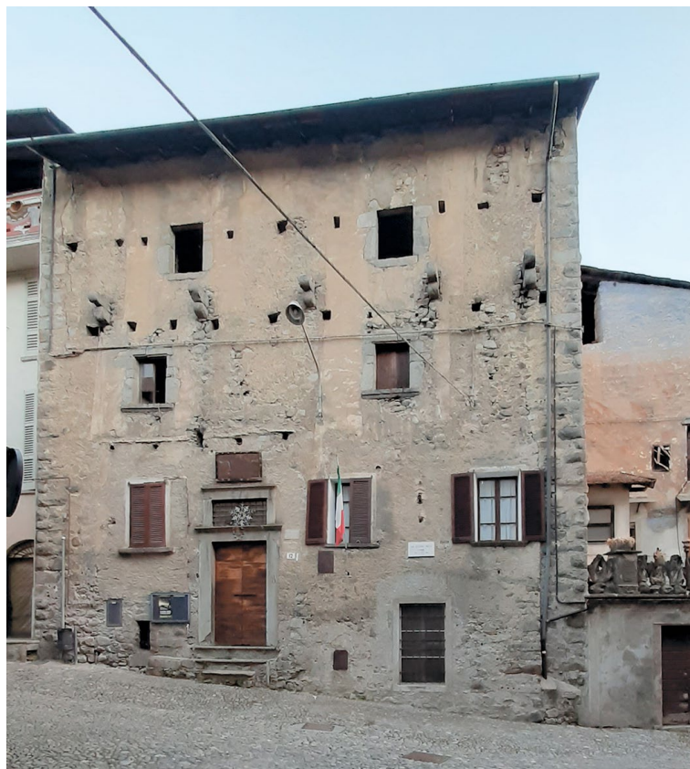
Figura 4. Facciata della casa della latteria (foto Davide Borromeo).
