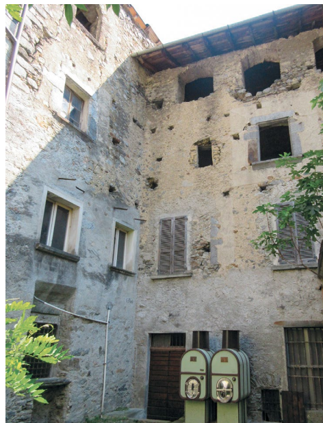
Figura 29. Ponte, via Giuseppe Piazzi, 12. Lato Est del prospetto sul cortile (foto Francesca Bormetti).
