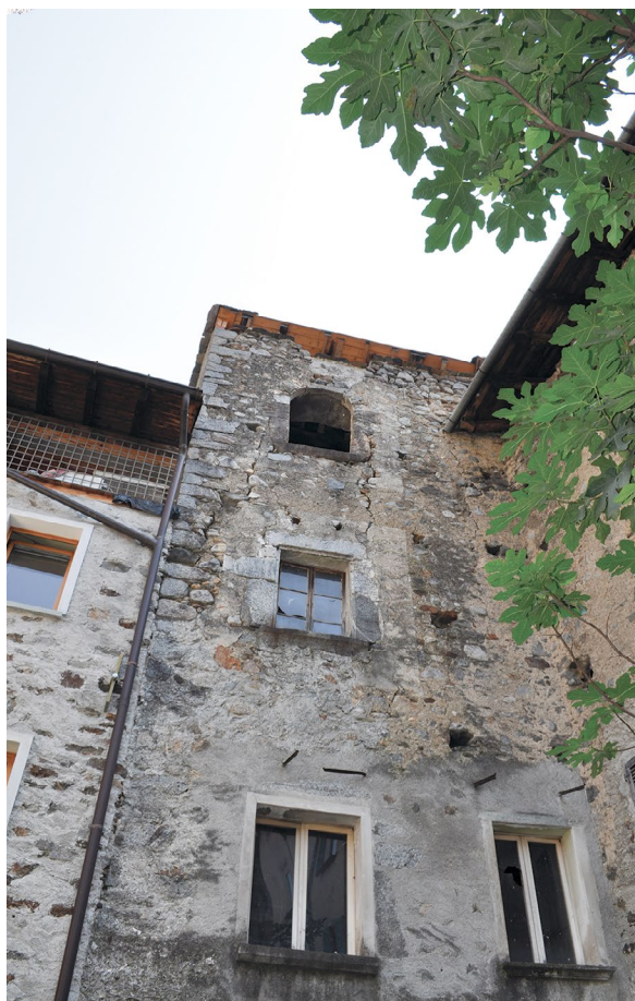
Figura 9. Casa della latteria, facciata nord, in evidenza la torre (foto Davide Borromeo)
