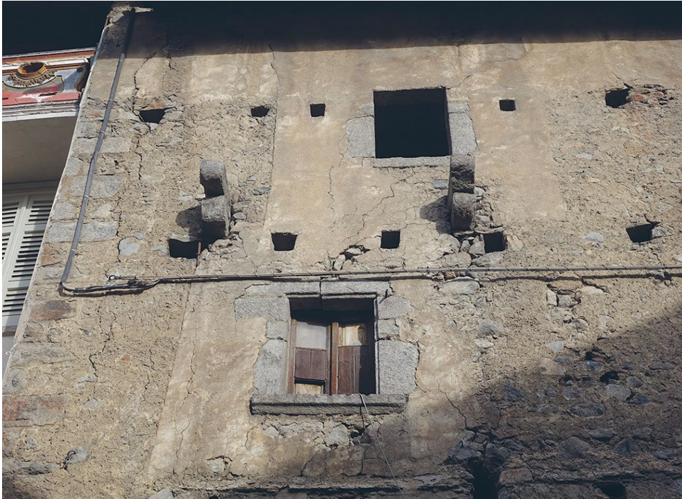
Figura 14. Ponte, via Giuseppe Piazza, 12. Finestre della facciata su strada, lato Ovest (foto Francesca Bormetti).
