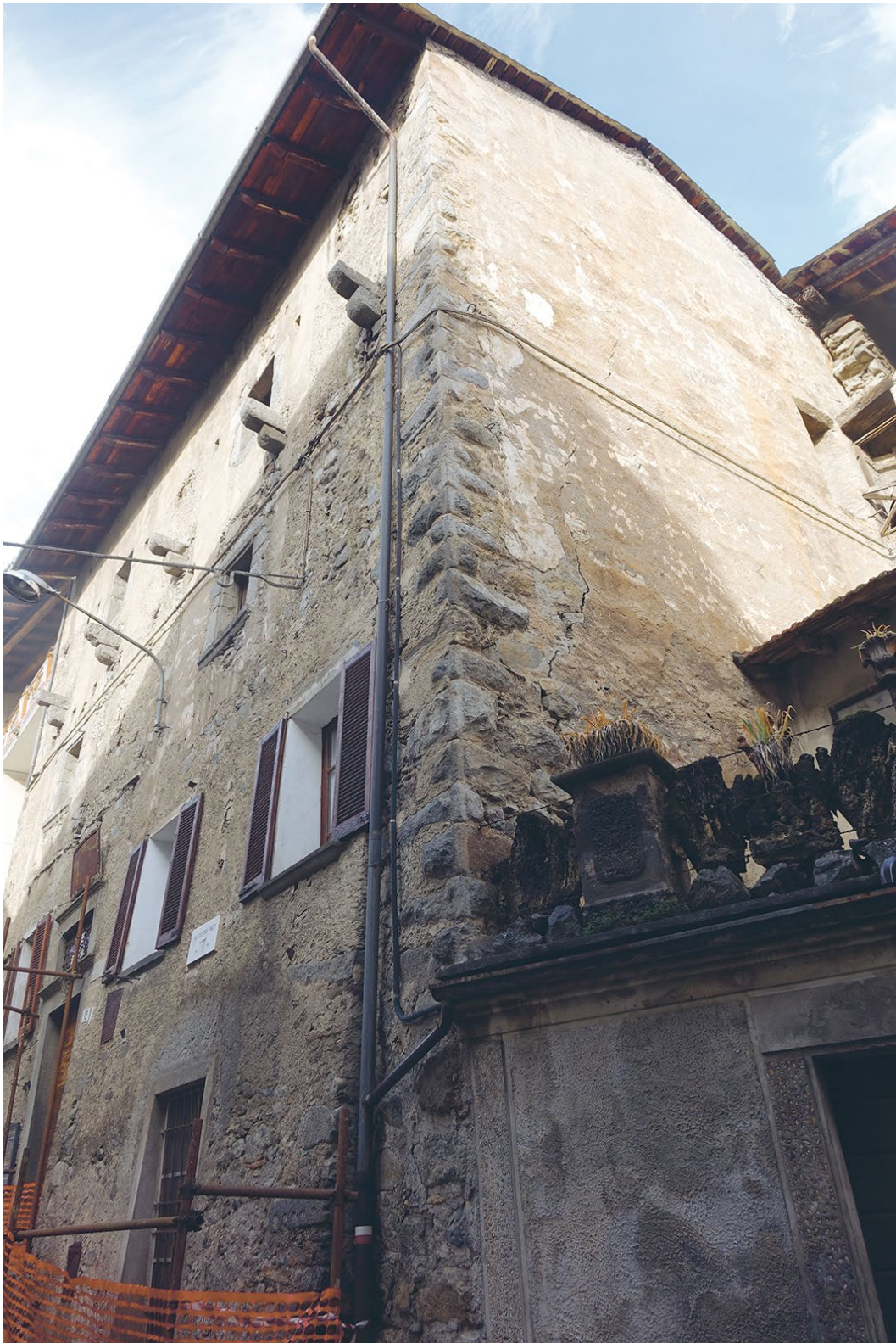
Figura 12. Ponte, via Giuseppe Piazzi, 12. Prospetti Sud ed Est con cantonali di grosse pietre (foto Francesca Bormetti).
