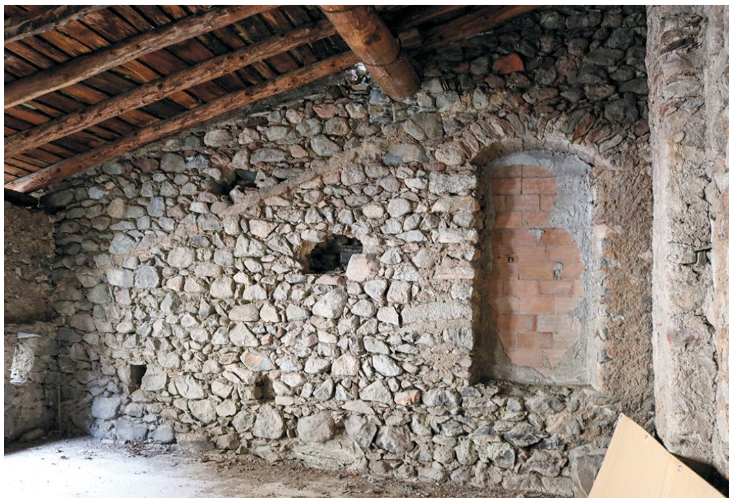
Figura 41. Ponte, via Giuseppe Piazzi, 12. Parete di fondo dell'andito al terzo piano con ingresso tamponato per il passaggio verso la casa torre (foto Francesca Bormetti).
