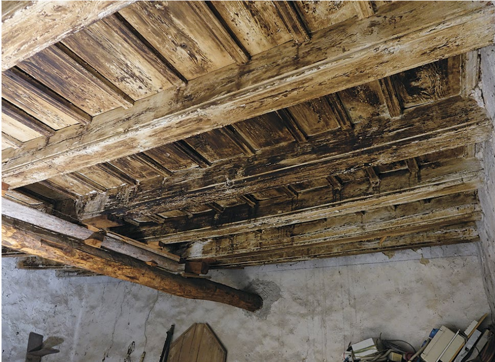
Figura 27. Ponte, via Giuseppe Piazzi, 12. Secondo piano, prima stanza, particolare del soffitto ligneo (foto Francesca Bormetti).
