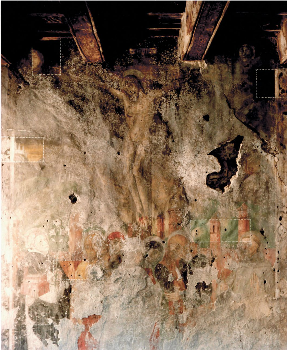
Figura 11. Ponte, casa della latteria. Gli affreschi prima del restauro (foto Vimercati).
